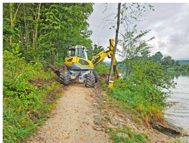
Realizzazione della condotta di scarico della pompa di calore per acque sotterranee nell'Aare (foto: Adrian Nutzi)
