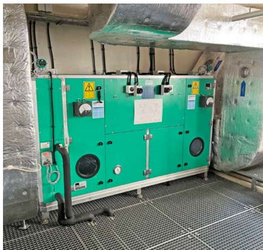
Componenti edili riutilizzati: unità di ventilazione, lampade a plafone e tegole per pareti divisorie (immagini: UFCL)
