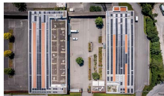
Installazione di due impianti fotovoltaici su due tetti del Centro delle collezioni del Museo nazionale svizzero di Affoltern am Albis. (Copyright: Museo nazionale svizzero)
