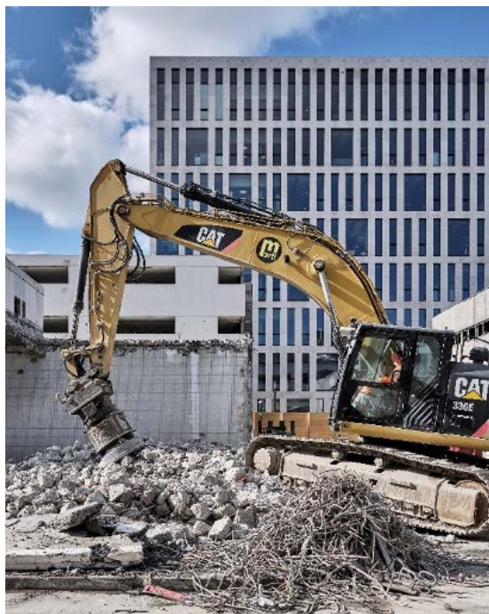
Nel corso della demolizione dell'autorimessa e della stazione di rifornimento i materiali sono stati separati in modo meticoloso. (foto: Rolf Siegenthaler)
