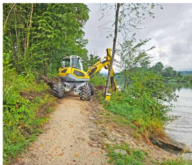
Construction de la conduite de retour de la pompe à chaleur sur nappe phréatique dans l'Aar (photo: Adrian Nutzi)
