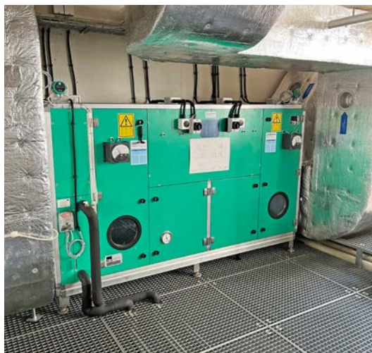
Éléments de construction réutilisés : système de ventilation, plafonniers et tuiles pour les cloisons (photos : OFCL)
