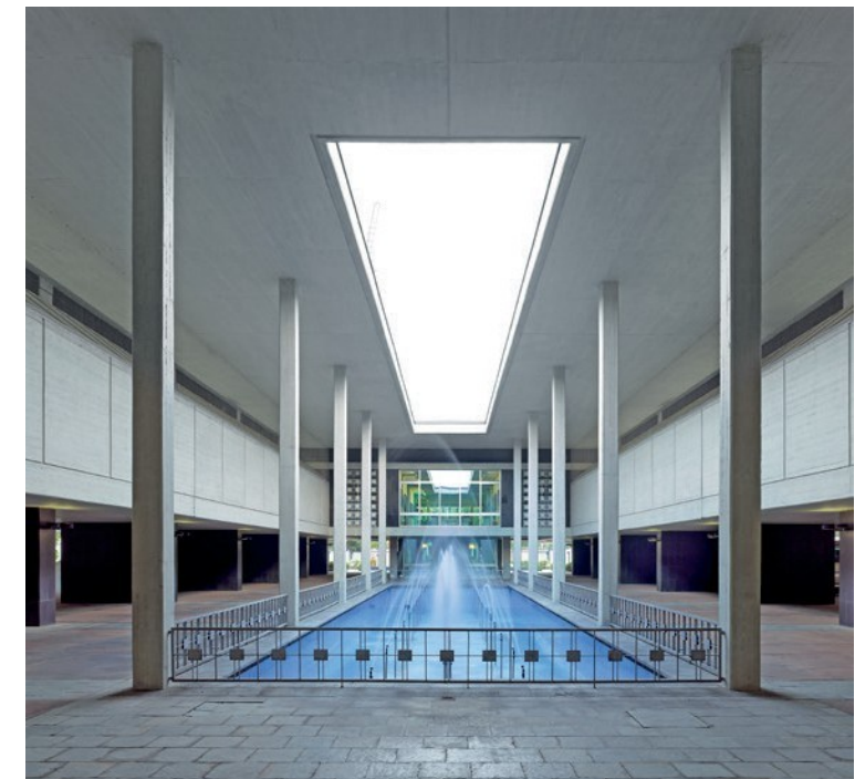
Schweizerische Botschaft in New Delhi (107) Auch die Gebäudetypologie trägt zur guten Energieperformance bei. So sorgen der Innenhof und das Wasser für spürbare Frische.
