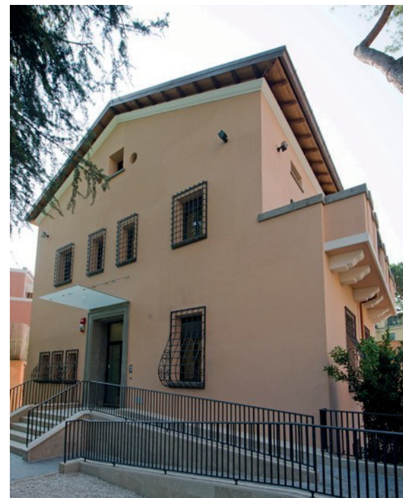
Kanzlei der Schweizerischen Botschaft in Rom (104) Bei der Renovation der Kanzlei wurde eine Rampe für Mobilitätsbehinderte oder Kinderwagen errichtet.
