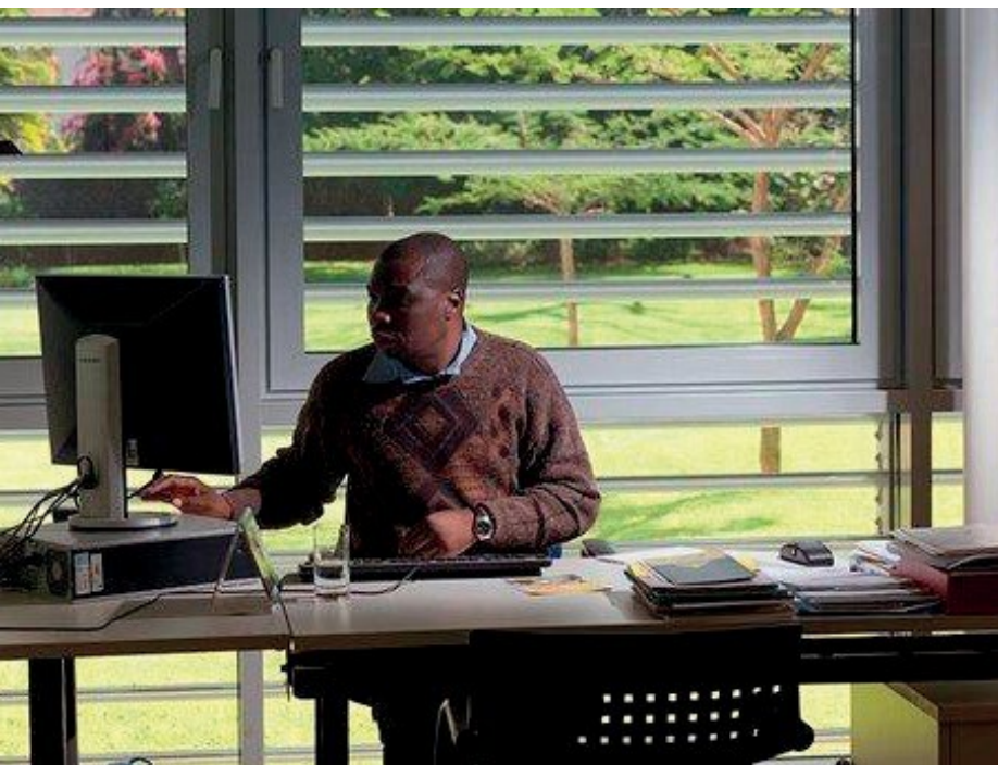
Schweizerische Botschaft in Harare (107) Aussenstoren mit verstellbaren Lamellen sind ein wirksames Mittel zur Bekämpfung der Gebäudeüberhitzung.
