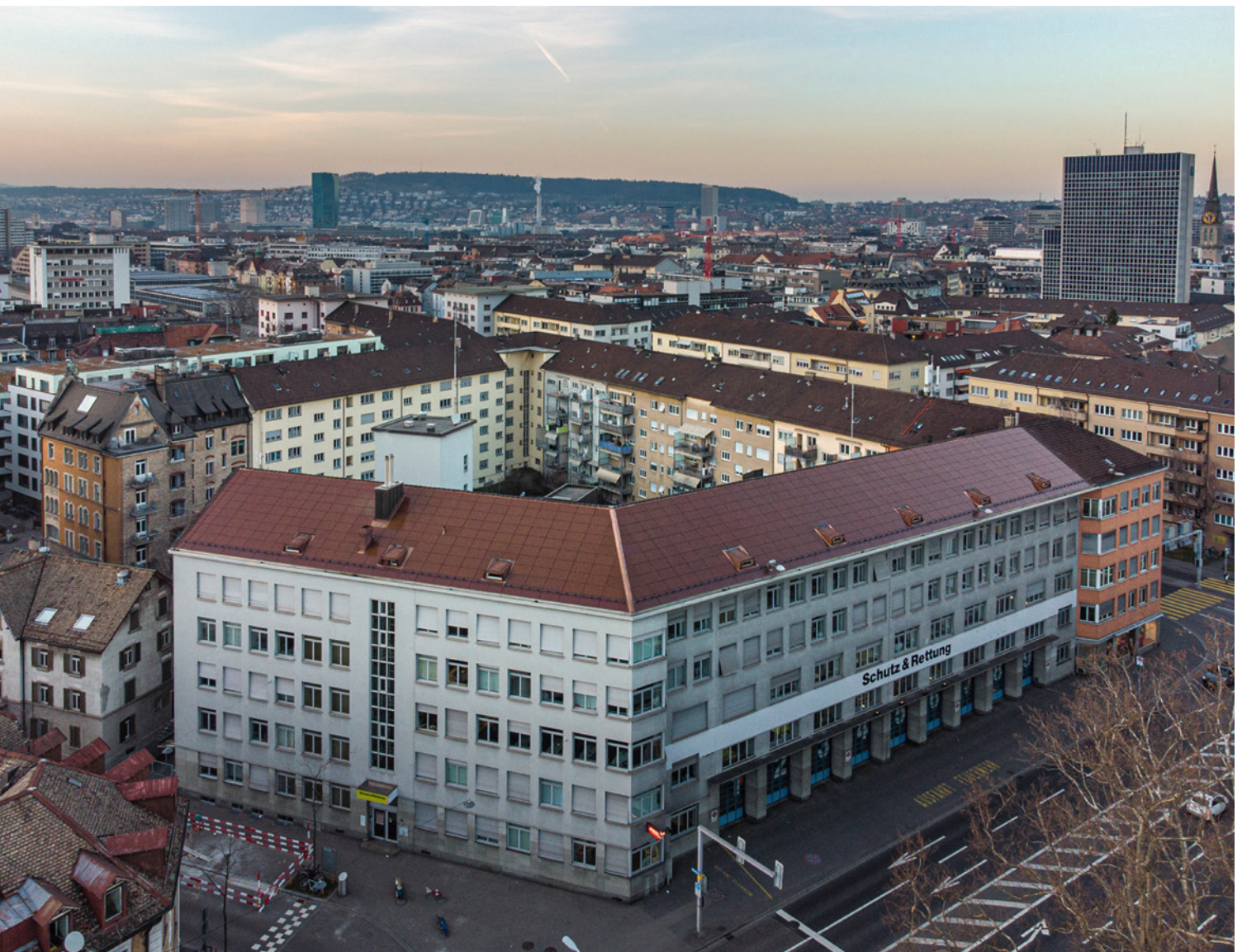
Das Dach des Hauptsitzes von Schutz & Rettung Stadt Zürich mit ziegelfarbenen PV-Modulen, realisiert 2021.
