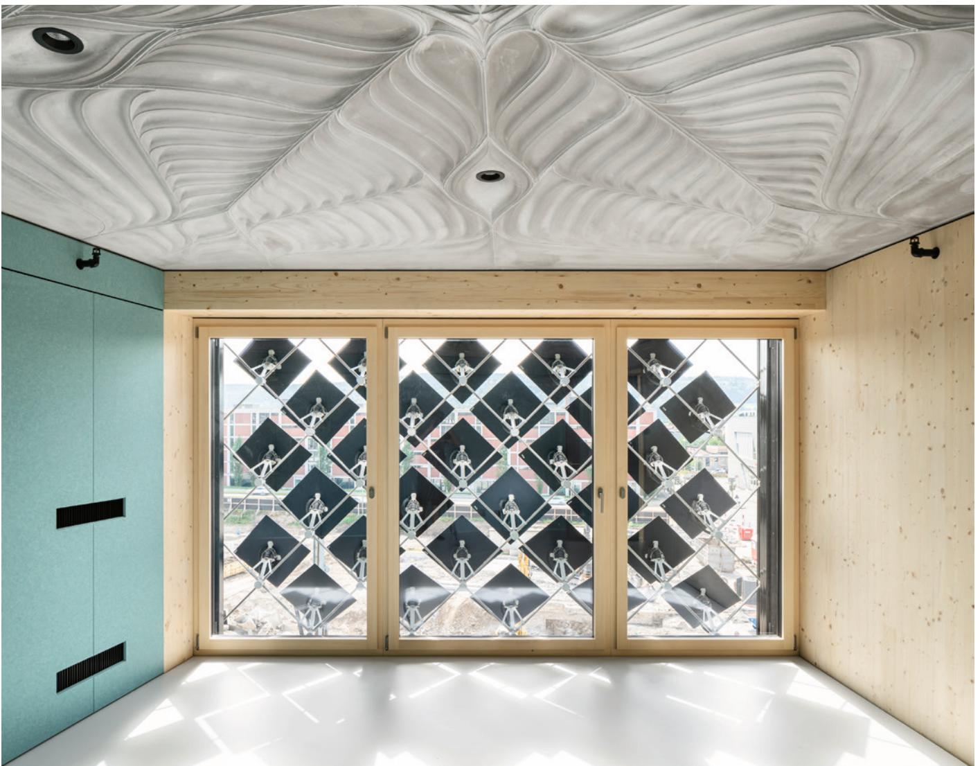
Modell- und Testkonstruktion der adaptiven Solarfassade «Solskin» am Forschungsgebäude NEST an der EMPA in Dübendorf.
