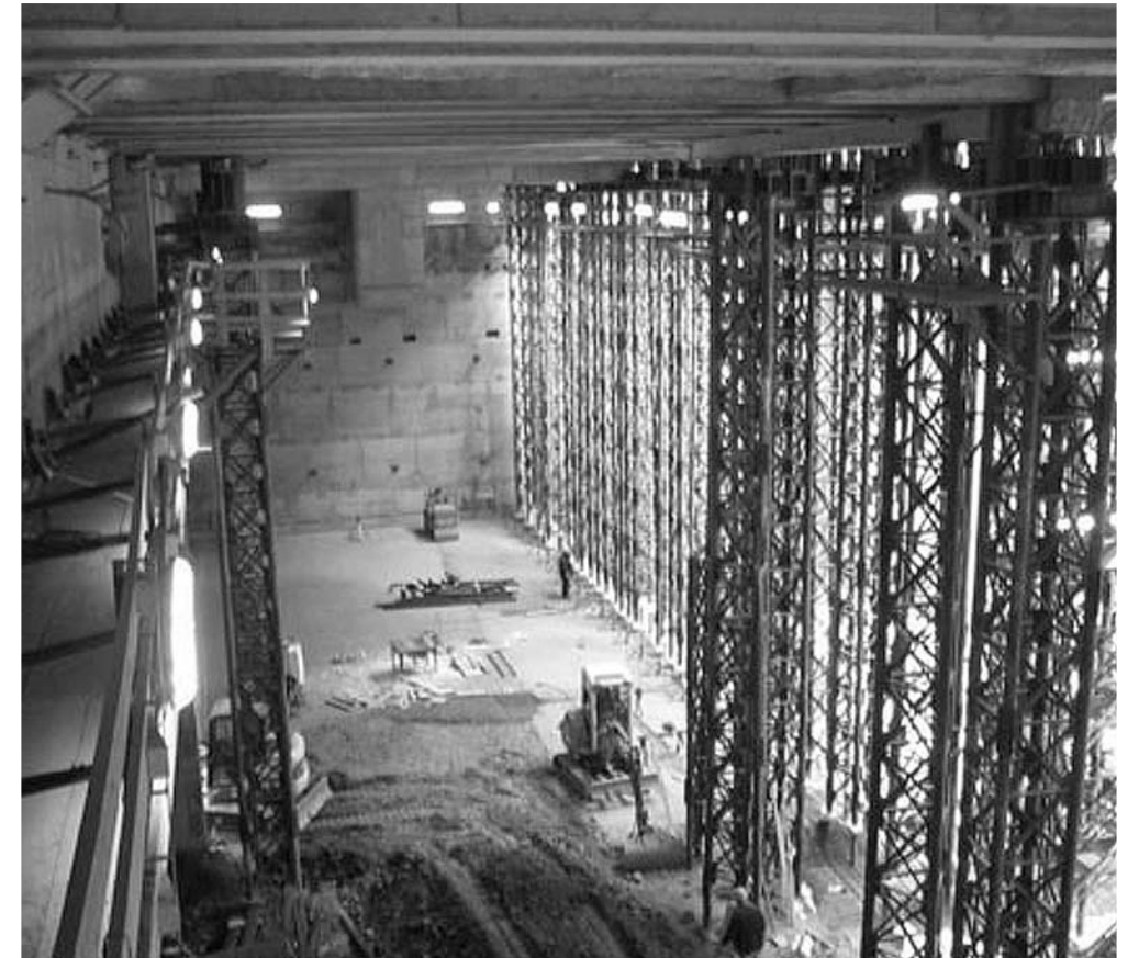
Aushub unter dem bestehenden Gebäude
