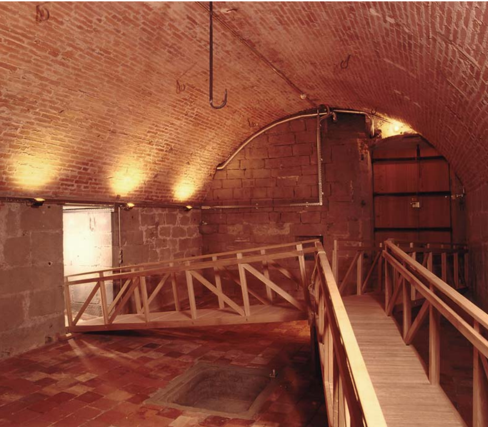
Steg im Gewölbekeller Ost
