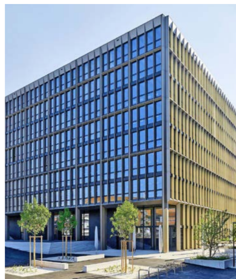
Nach SNBS Platin, Minergie-P-ECO sowie GI Gutes Innenraumklima zertifizierter Neubau am Eichenweg 5 in Zollikofen (Foto: Rolf Siegenthaler)
