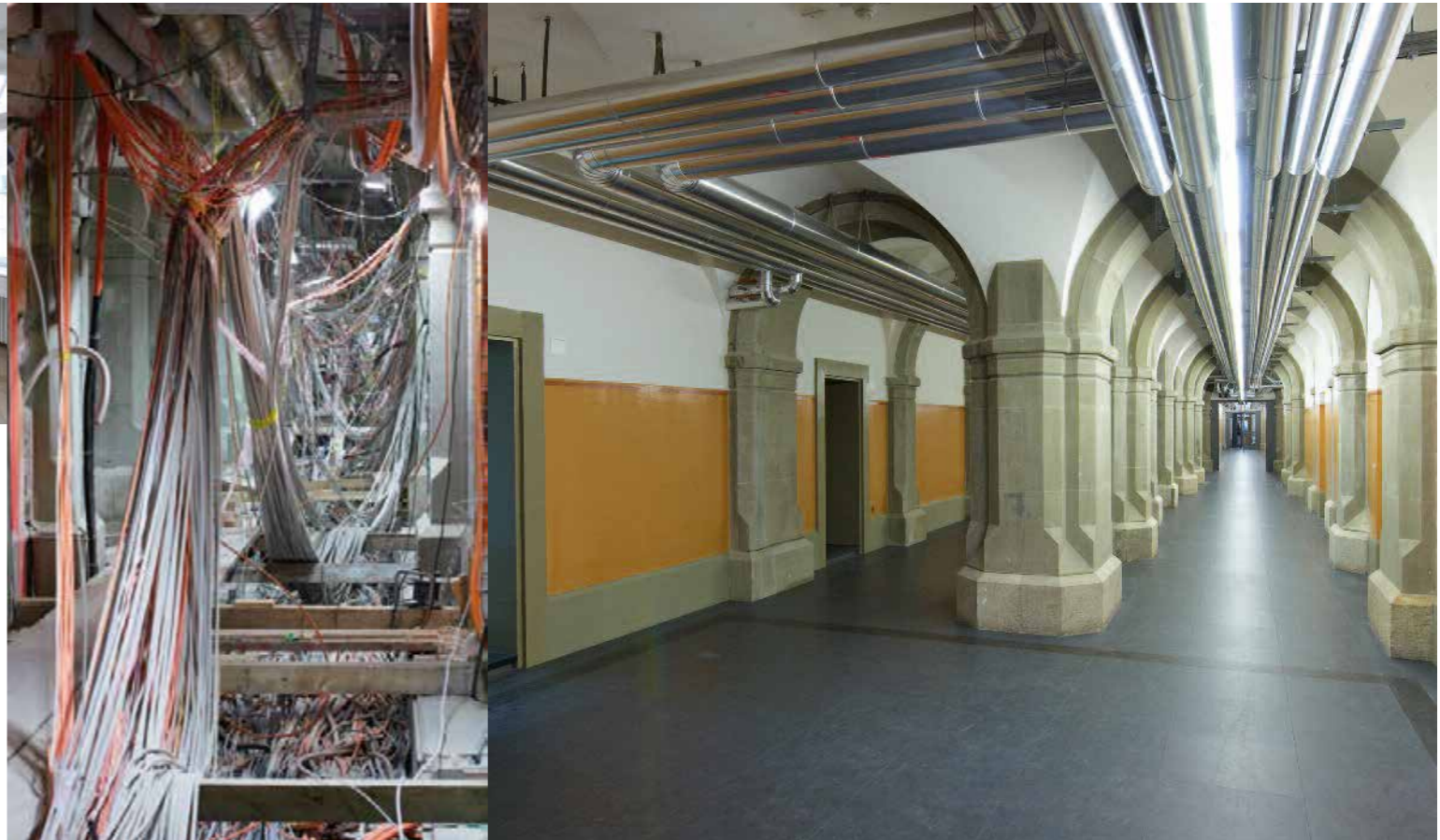
I cavi elettrici al soffitto, ora interrati sotto il pavimento sopraelevato
