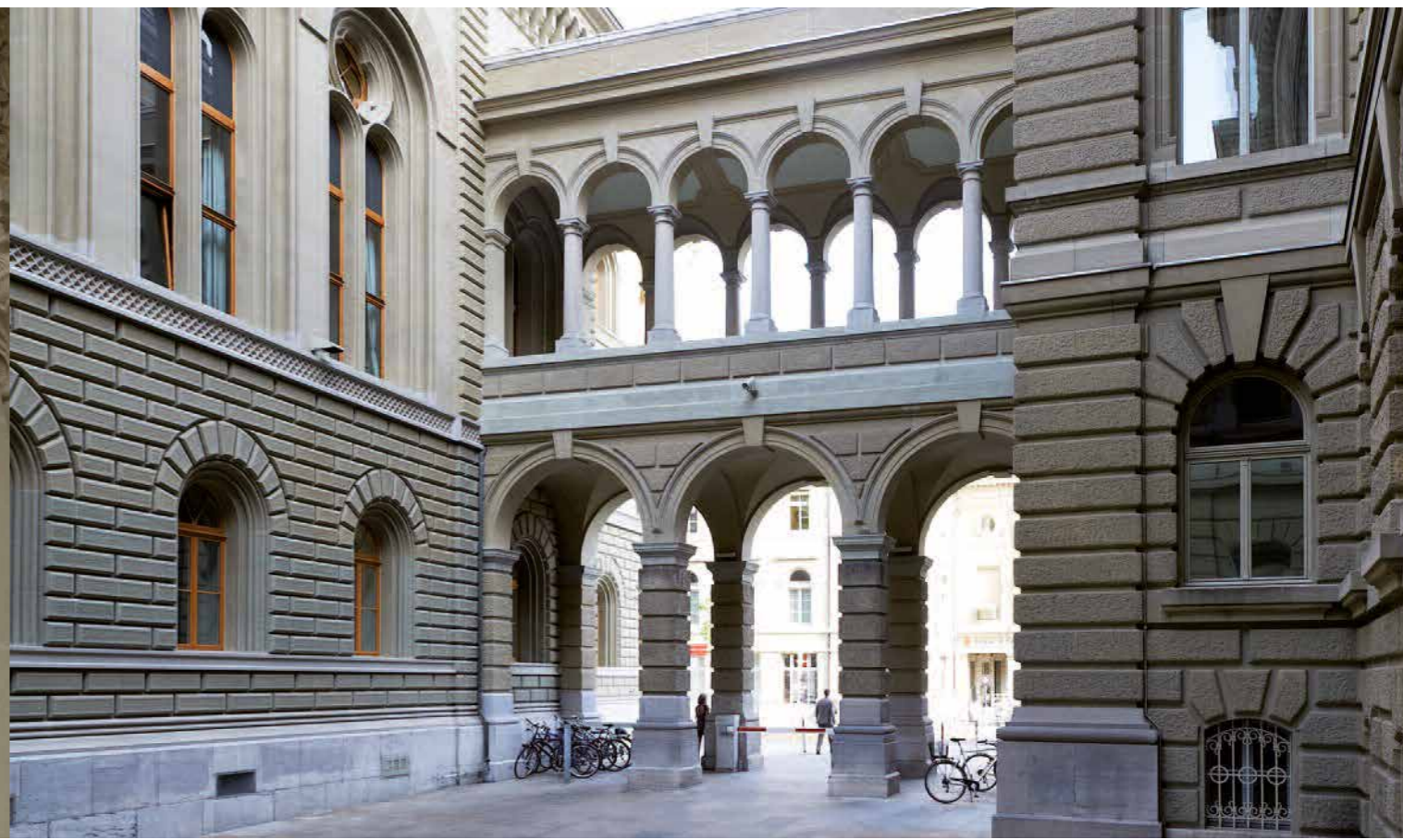
Passaggio fra Palazzo federale ovest e Palazzo del parlamento
