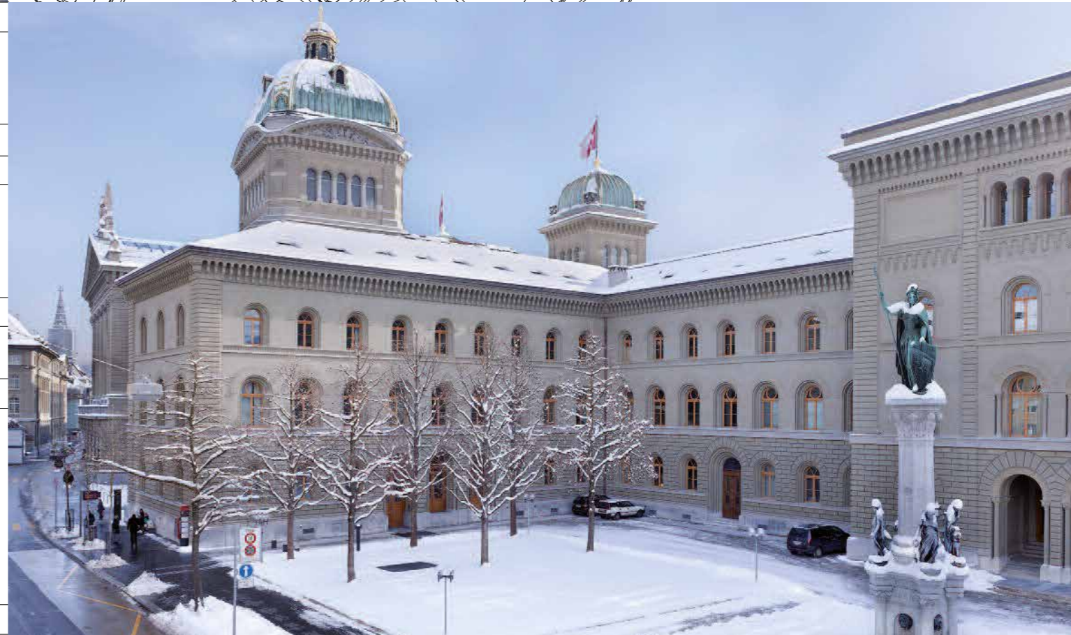
Vista sull'ala est e sul cortile d'onore dal lato nord
