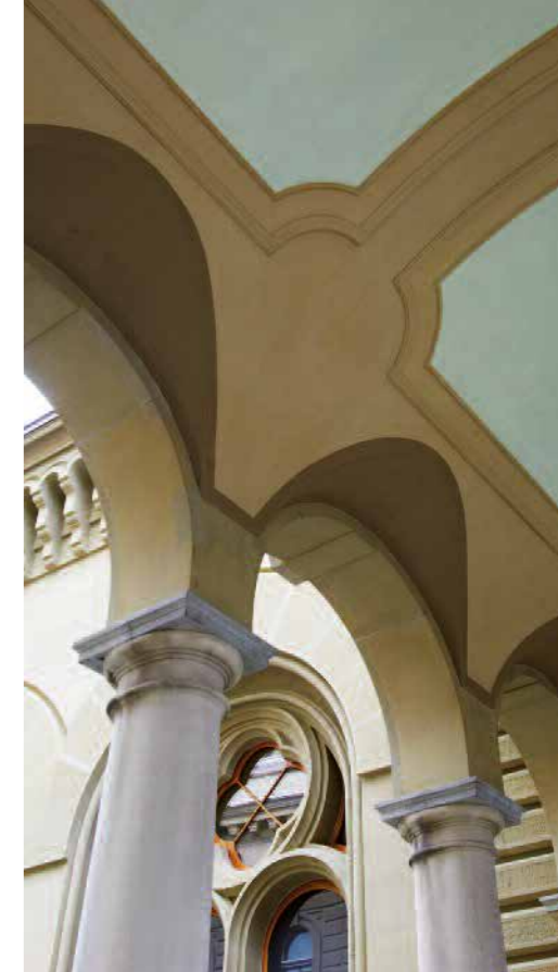
Portico dopo il restauro
