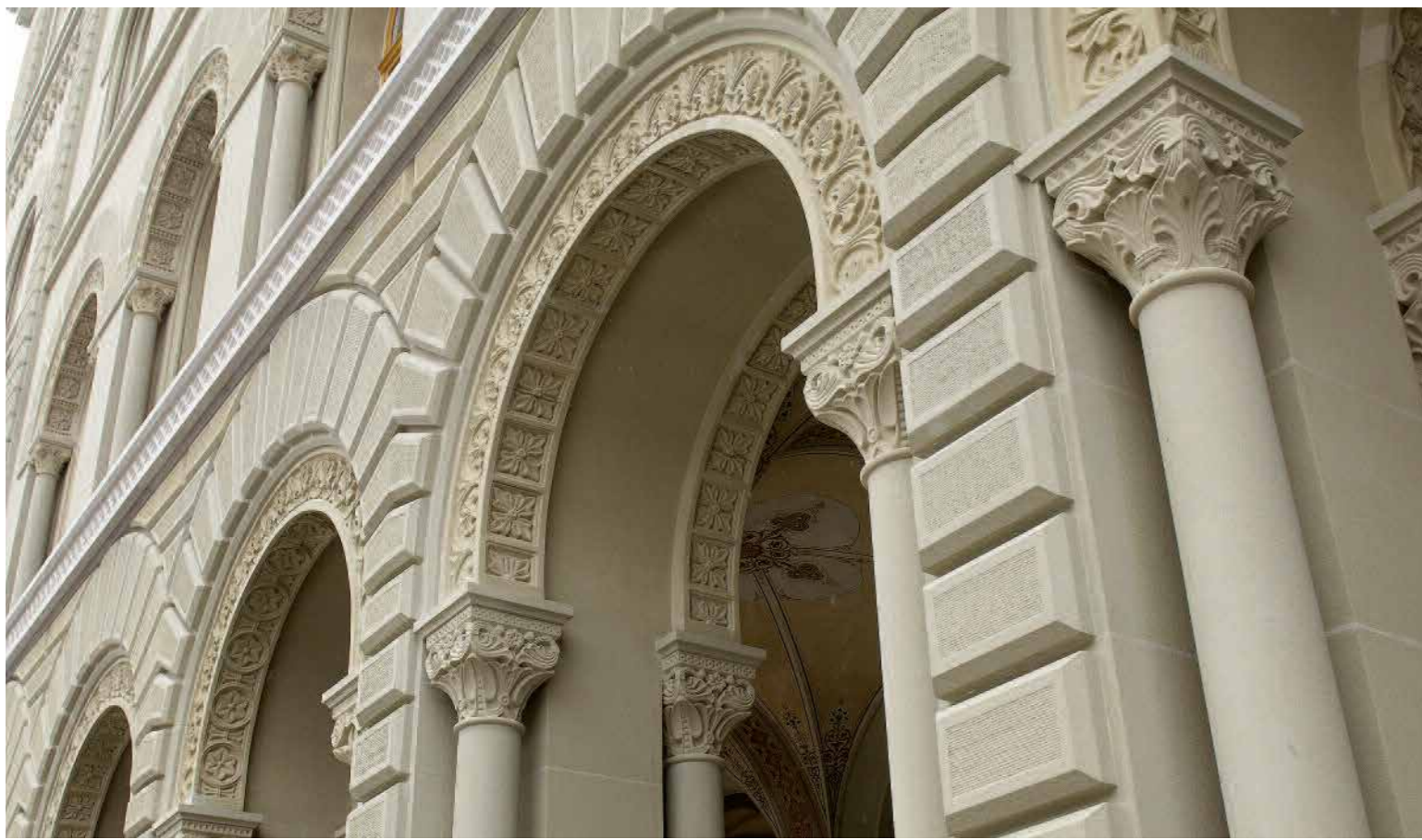
Ingresso principale dopo il risanamento
