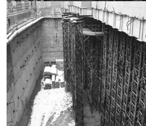
Micropali sotto la facciata verso il cortile
