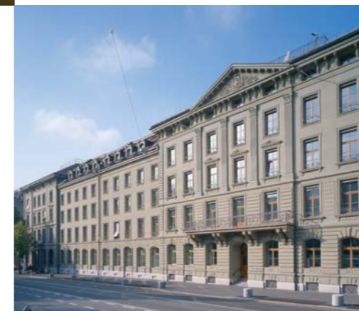
Facciata sulla Bundesgasse
