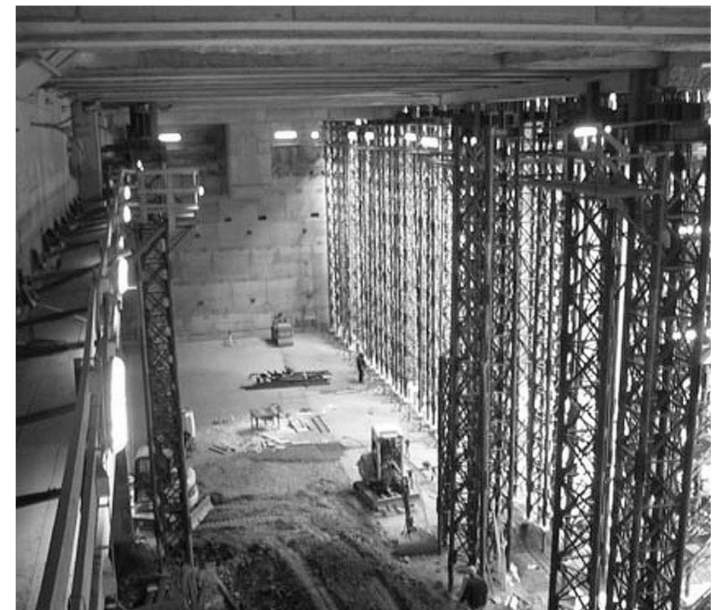
Lavori di scavo sotto lo stabile esistente
