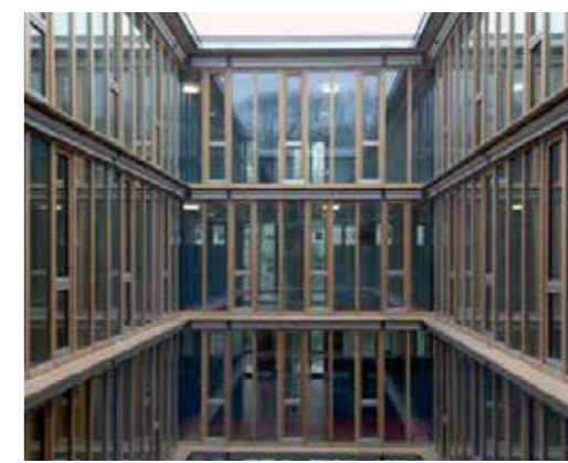
Mühlestrasse 6: cortile interno
