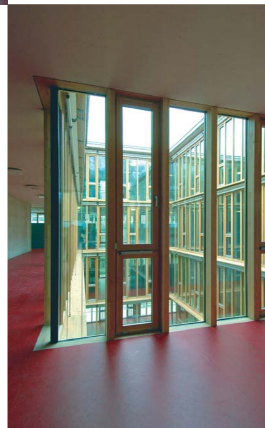
Mühlestrasse 6: corridoio sul cortile interno
