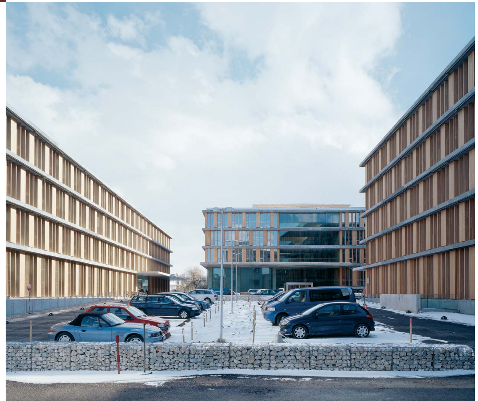
Vista complessiva da ovest
