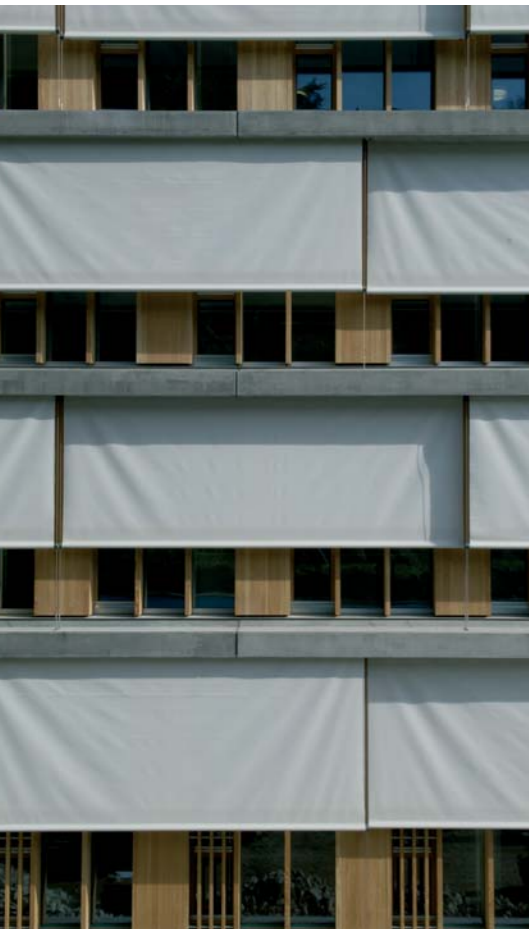
Particolare di facciata con ripari solari
