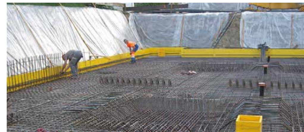
Piastra di fondazione: armatura
