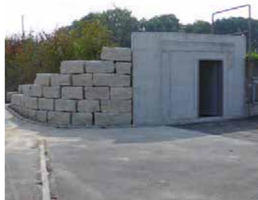
Ingresso all'impianto lisimetrico, con muro di contenimento
