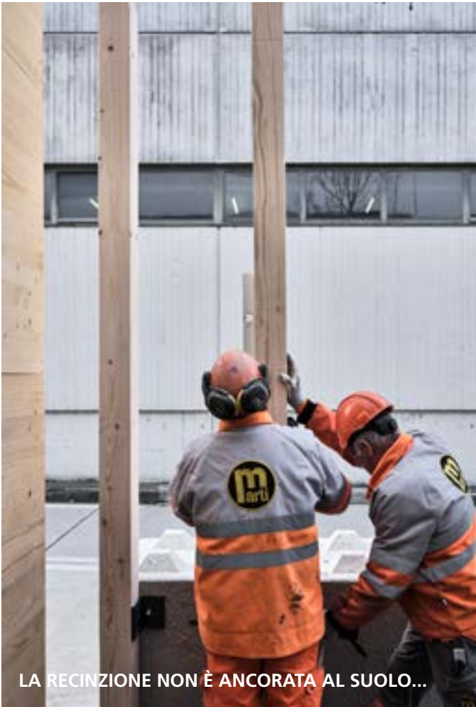
... BENSÌ STABILIZZATA CON ZAVORRE IN CALCESTRUZZO
