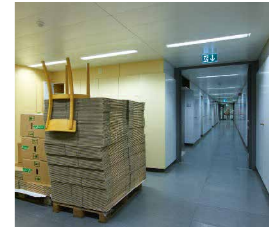
Sous-sol avant réhabilitation, avec un plafond métallique suspendu et des armoires intégrées
