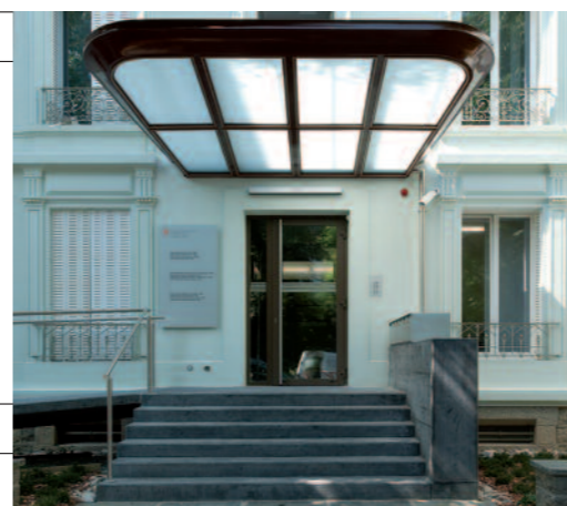
Entrée façade nord
