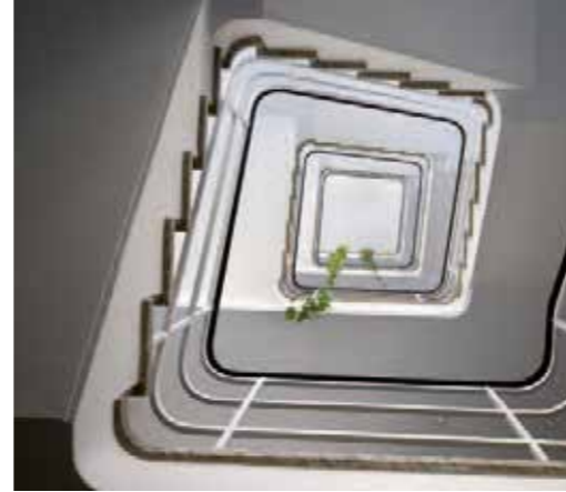
Cage d'escalier des années 1950
