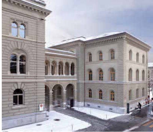
Aile est, liaison nord avec la terrasse fédérale
