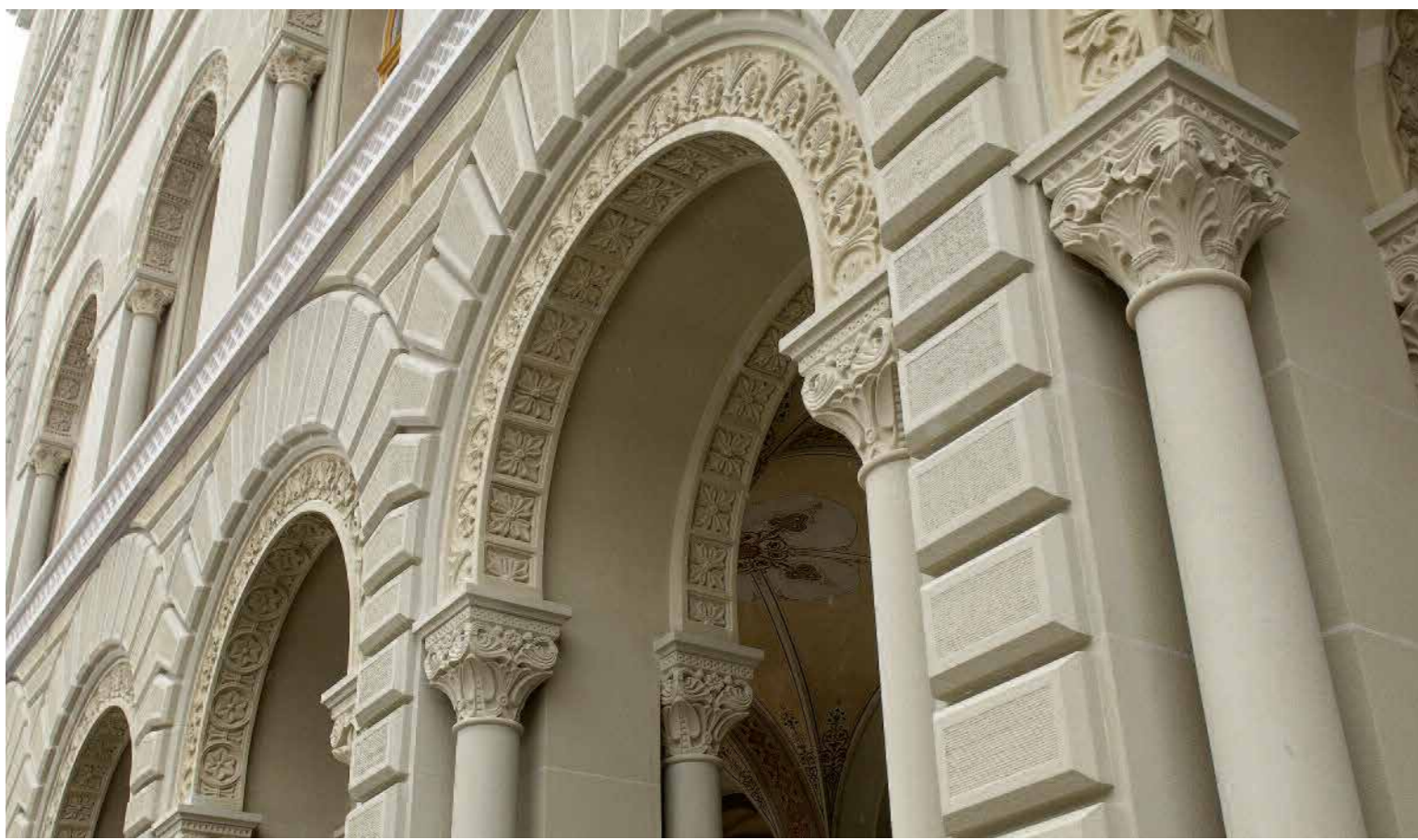
Entrée principale réhabilitée
