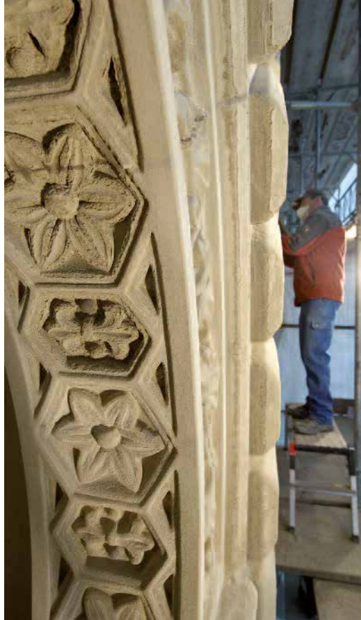
Ornements sur les arcs en plein cintre de l'entrée principale, en haut avant traitement et en bas après réhabilitation.
