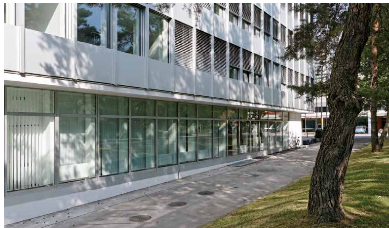
Passage côté est
