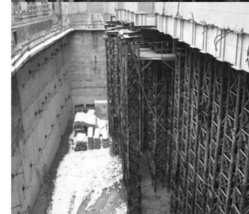
Micropieux de la façade sur cour
