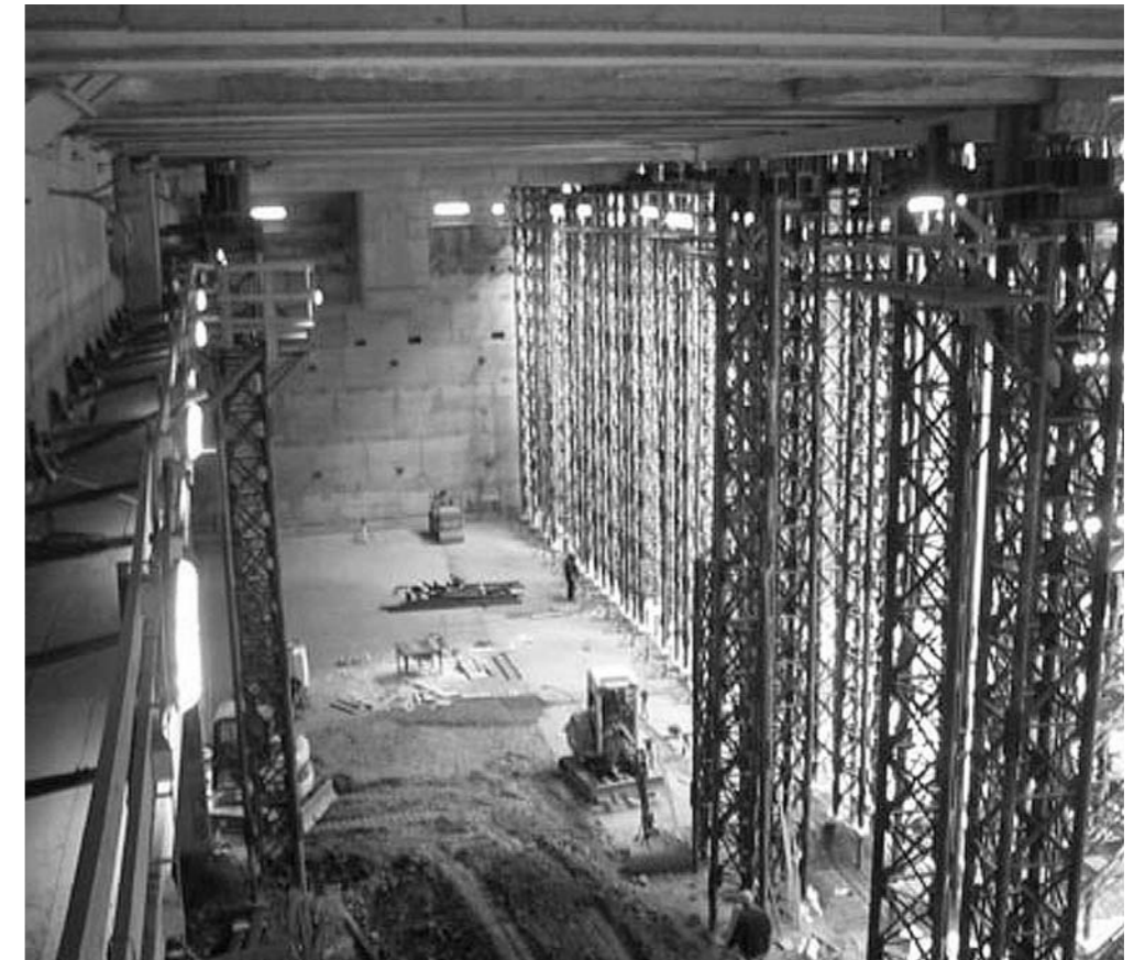
Excavation sous le bâtiment existant
