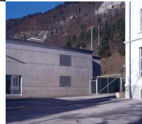
Façade côté cour de Administration II
