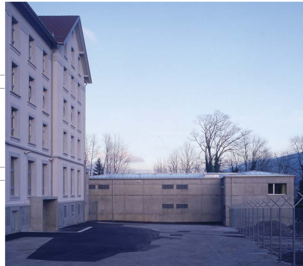
Façade côté cour de Administration I
