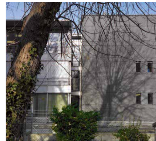
Façade partielle sud-est
