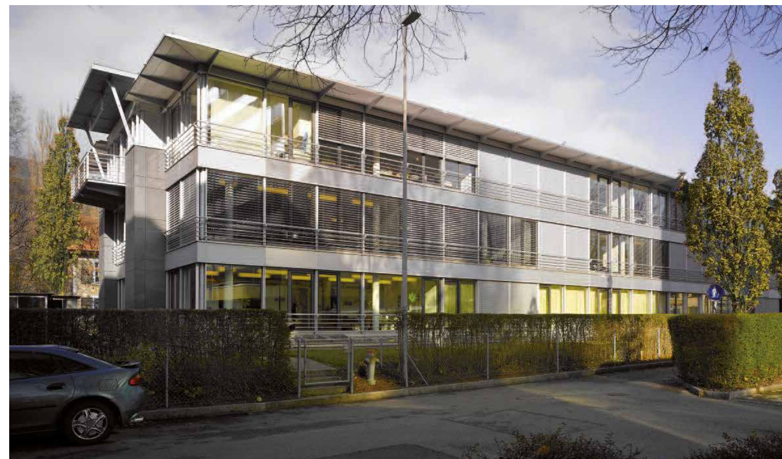
Angle sud-est du bâtiment
