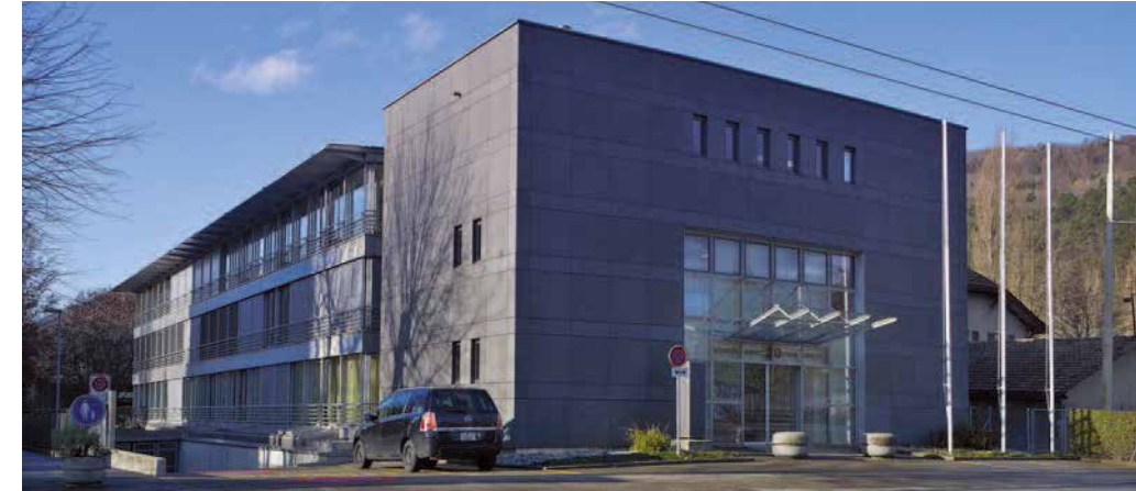
Angle nord du bâtiment
