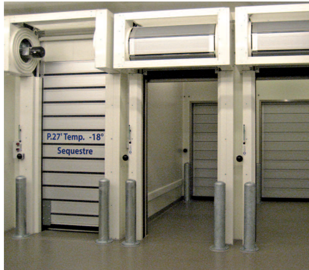
Locaux de stockage
