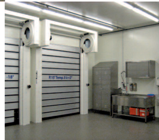
Locaux de contrôle
