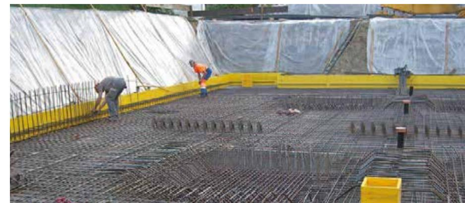
Pose d'un revêtement en béton à haute résistance sous les cylindres en béton des lysimètres ne permettant pas la pesée
