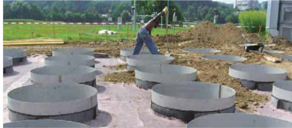
Étanchéité à l'eau avec une couche de protection protégeant la dalle.
