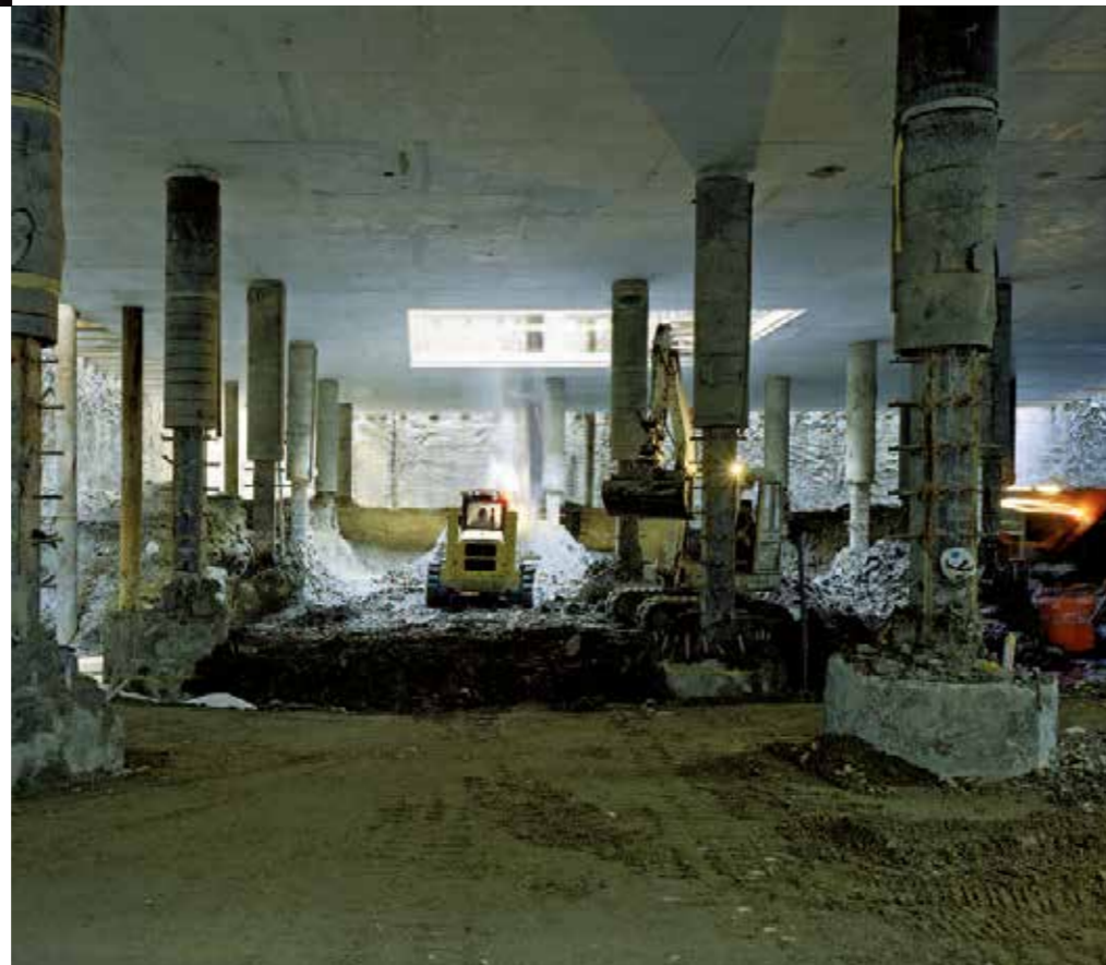
Niveau le plus bas atteint par les excavations
