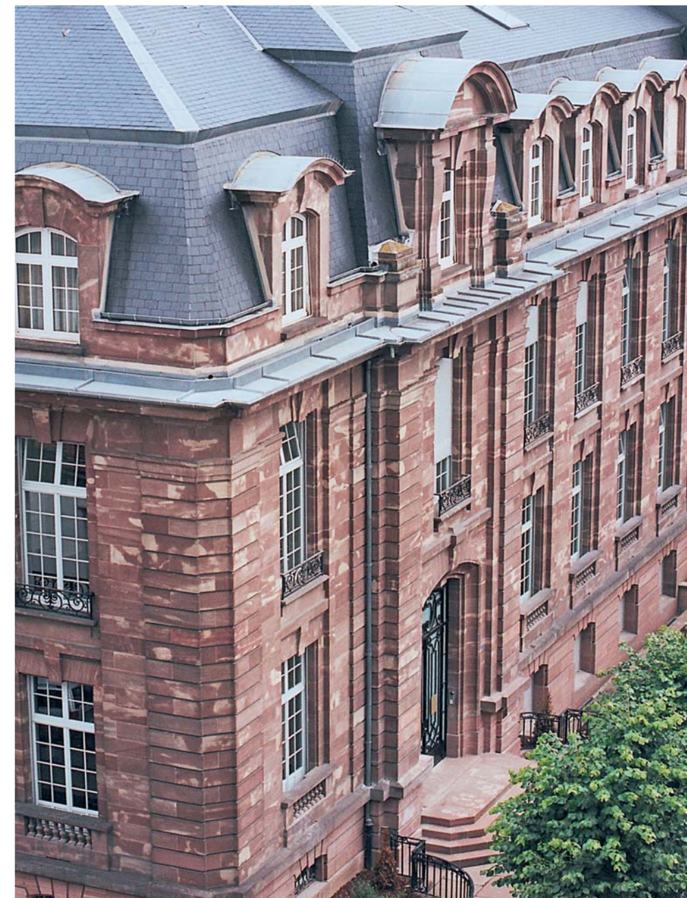
Vue extérieure partielle
