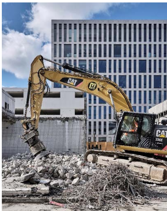
Lors de la démolition des garages et de la station-service, les matériaux sont soigneusement triés. (Photo: Rolf Siegenthaler)
