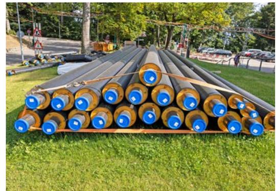
Condutture della nuova rete di teleriscaldamento a Macolin (foto: UFSPO)
