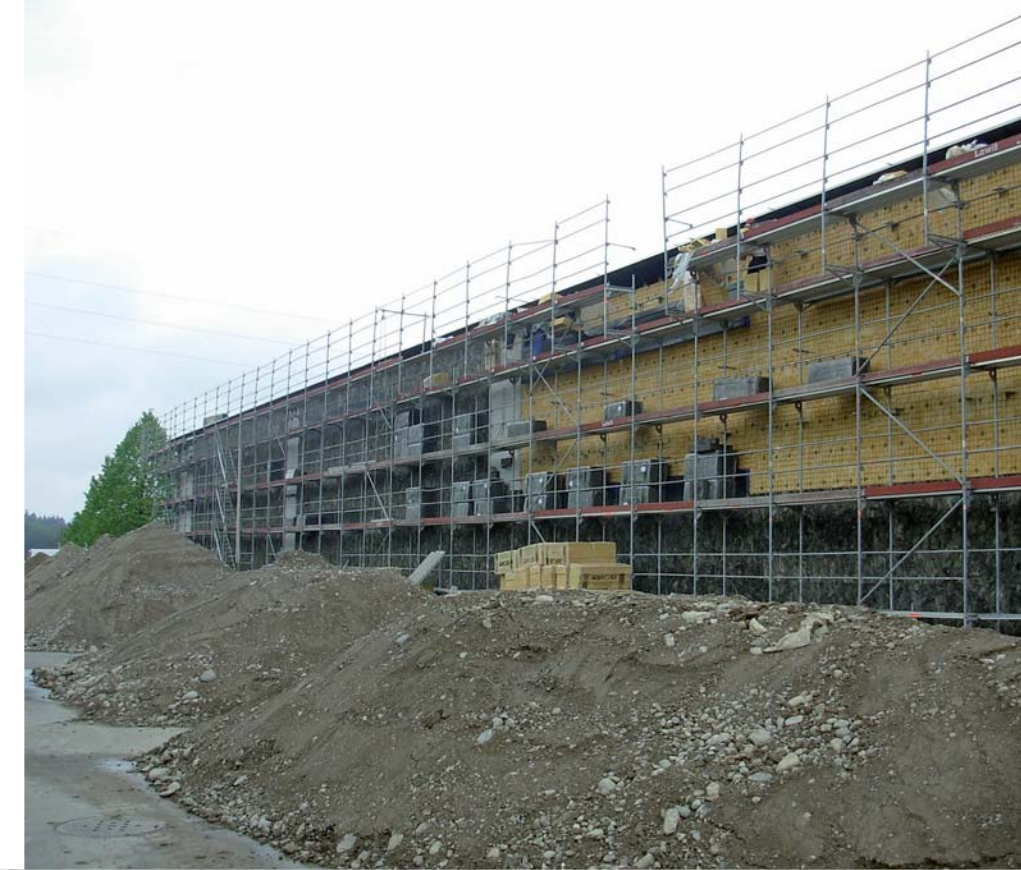
Anbringen der 2-lagigen Wärmedämmung (für Minergie P)
