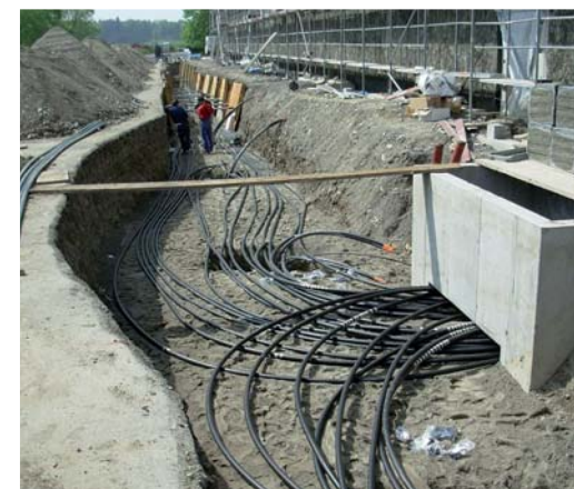
Geothermale Bohrungen (Erdwärmesonden)
