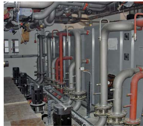
Verrohrung der Wärmepumpen (Rohinstallation)
