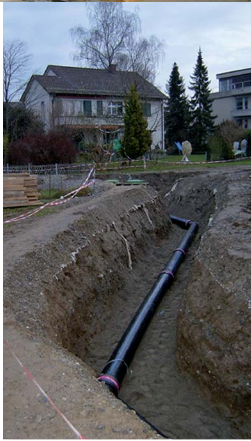
Grundwassererschliessung im Erdbereich
