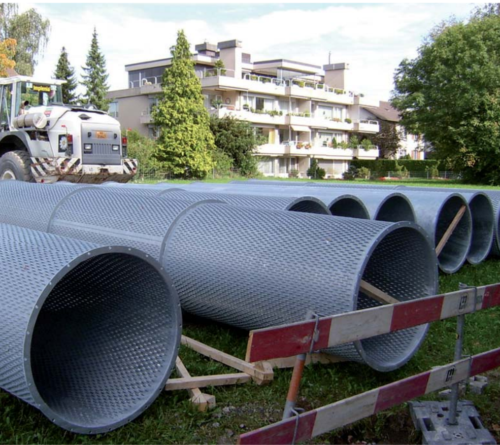
Filterrohre vor dem Einbau
