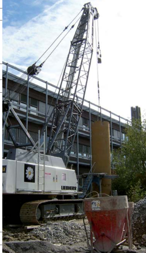
Bohren des Rückgabebrunnens
