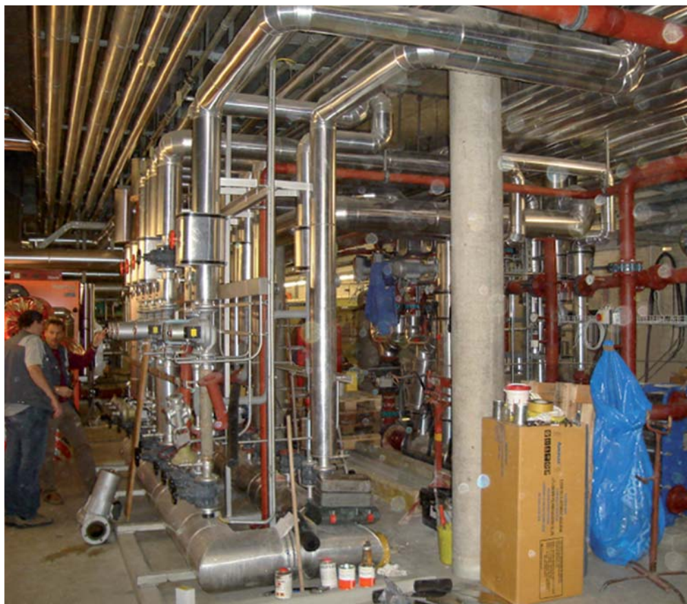
Verrohrung in Zentrale
