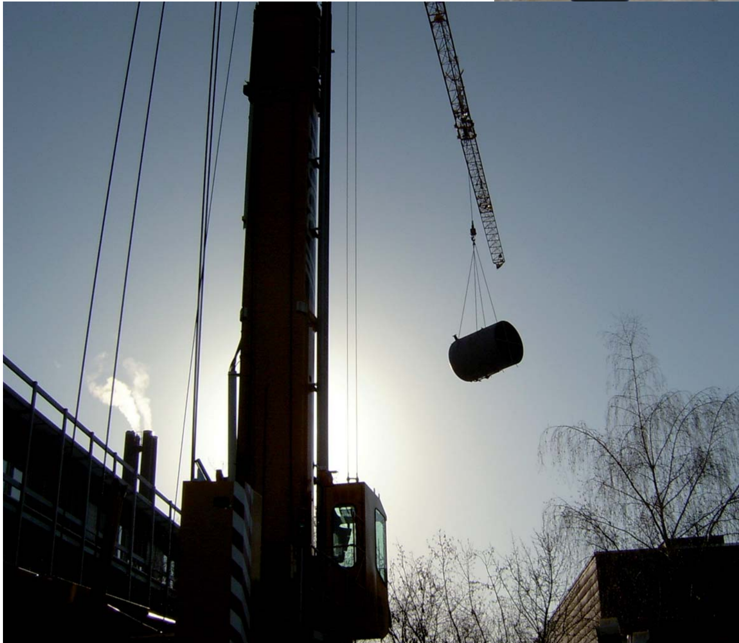
Einbringung der Wärmespeicher
