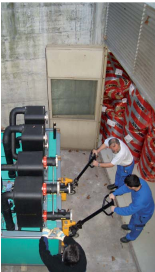
Einbringung der Wärmepumpe/Kältemaschine
