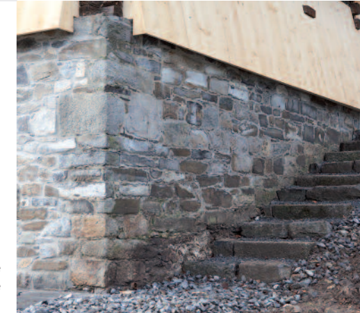
Aussentreppe Obere Scheune
