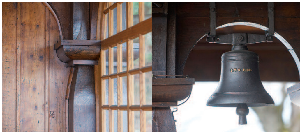
Detail Eichenstütze mit Sprossenfenster
