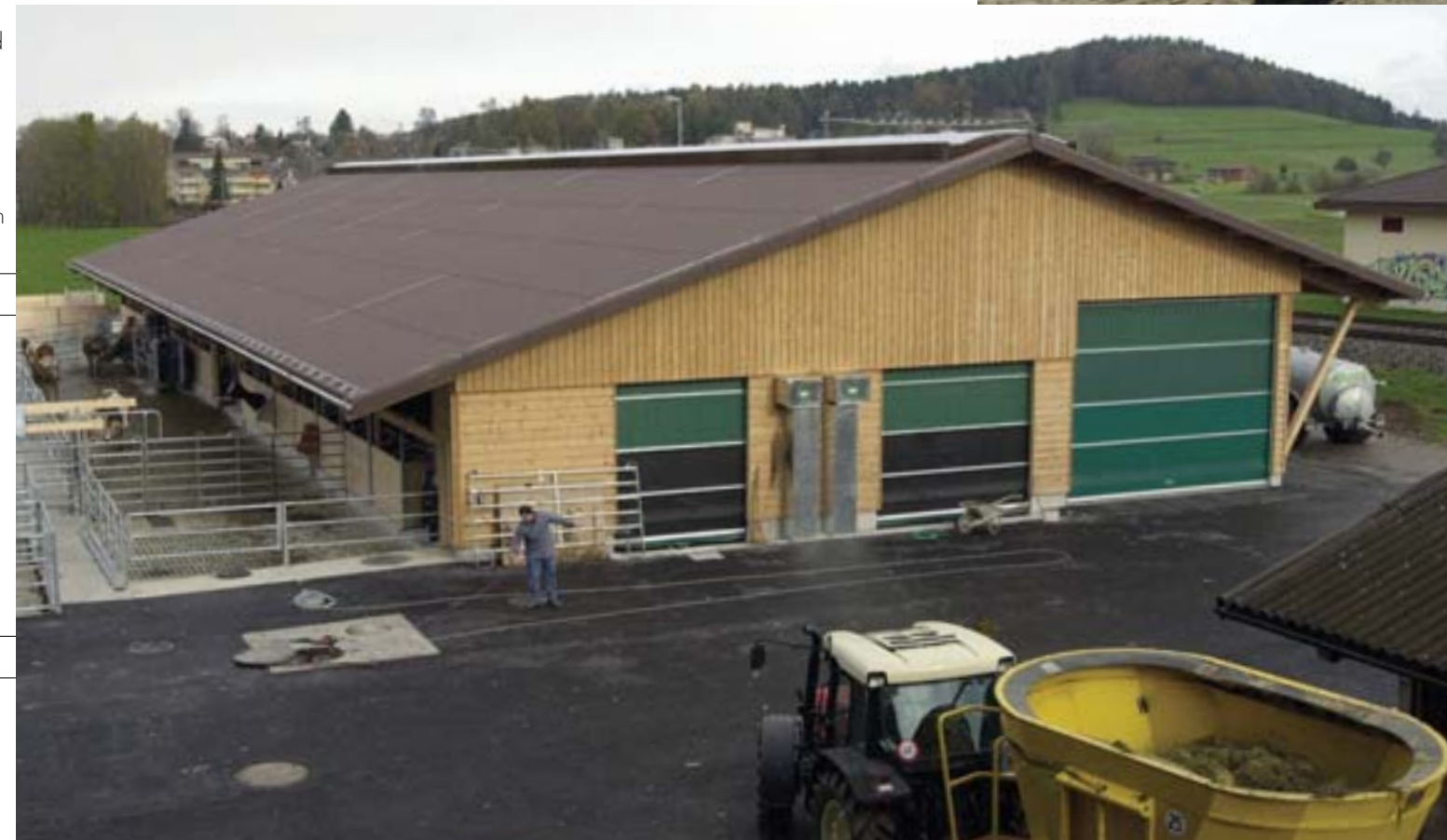
Ansicht Milchviehstall von Süden, Boxenlaufstall mit Laufhof, Futtermischwagen
