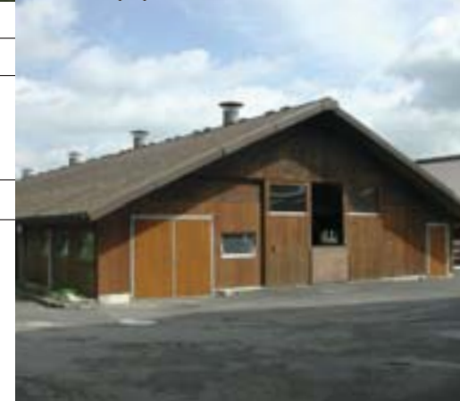
Ansicht Anexgebäude von Süden
