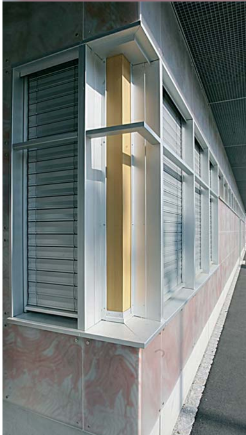
Detail Eingang Reisendenverkehr
