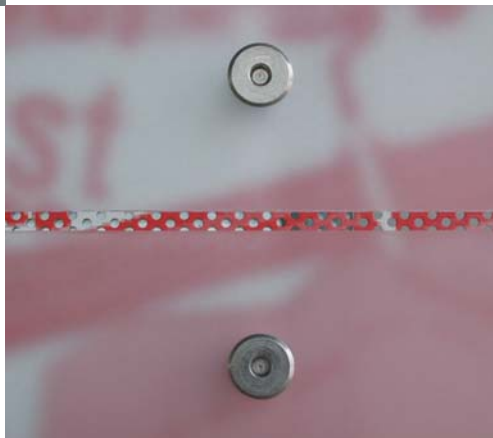
Ausschnitt Fassade Reisendenverkehr
