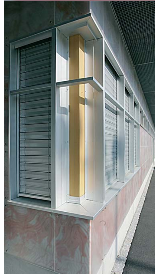
Detail Eingang Reisendenverkehr
