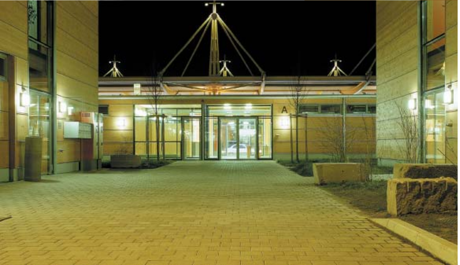
Hofansicht West, Gebäude C,A und B
