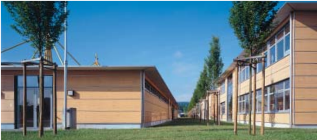
Ansicht Nord, Gebäude A und C
