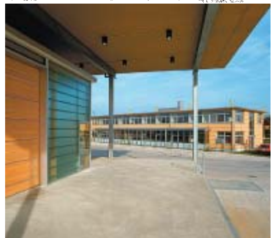
Gebäude D, Rampe
