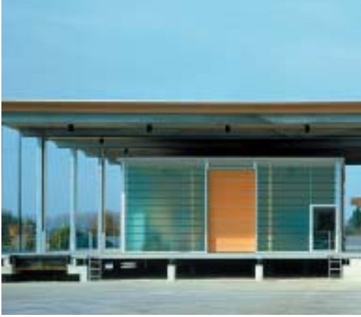
Ansicht Südost, Gebäude D
