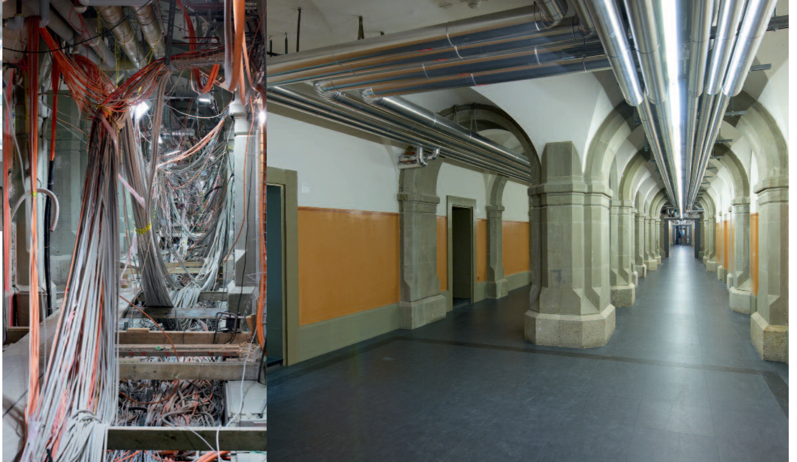
Saniertes Tiefparterre im Bereich Mittelrisalit
