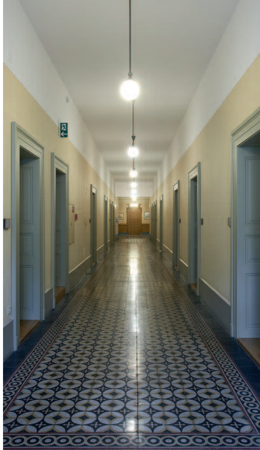
Sanierter Korridor, Ostflügel 1.OG
