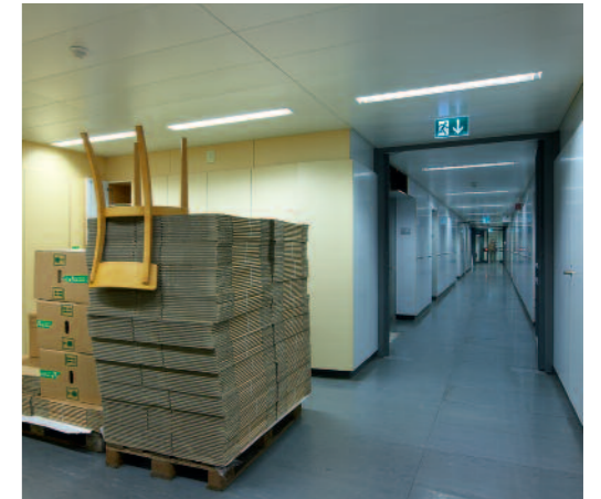
Tiefparterre vor der Sanierung mit abgehängter Metalldecke und Einbauschränken
