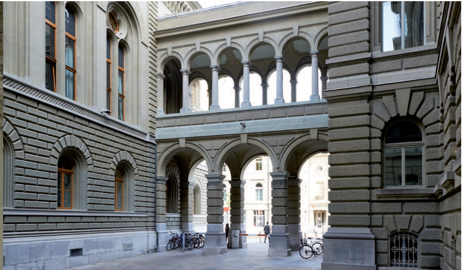
Durchgang zwischen Bundeshaus West und Parlamentsgebäude
