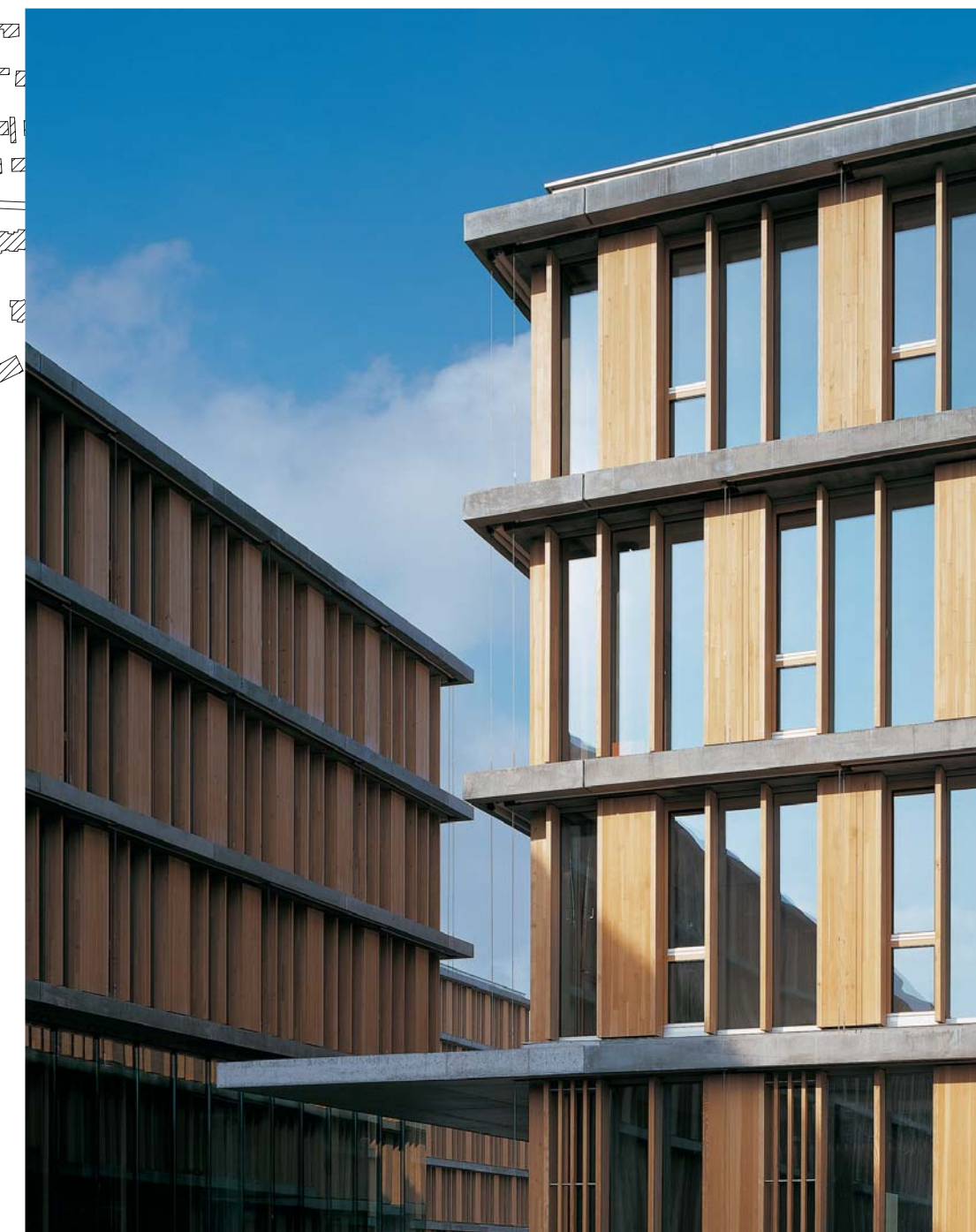
Ausschnitt der 3 Gebäude von Osten
