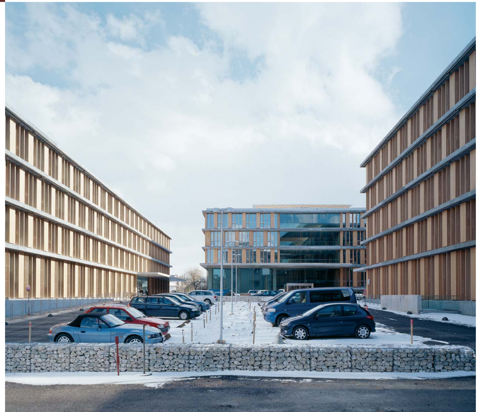
Gesamtansicht aus Westen
