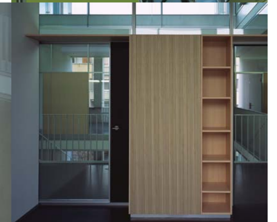
Trennwand Büro-Korridor (Büroseitig)
