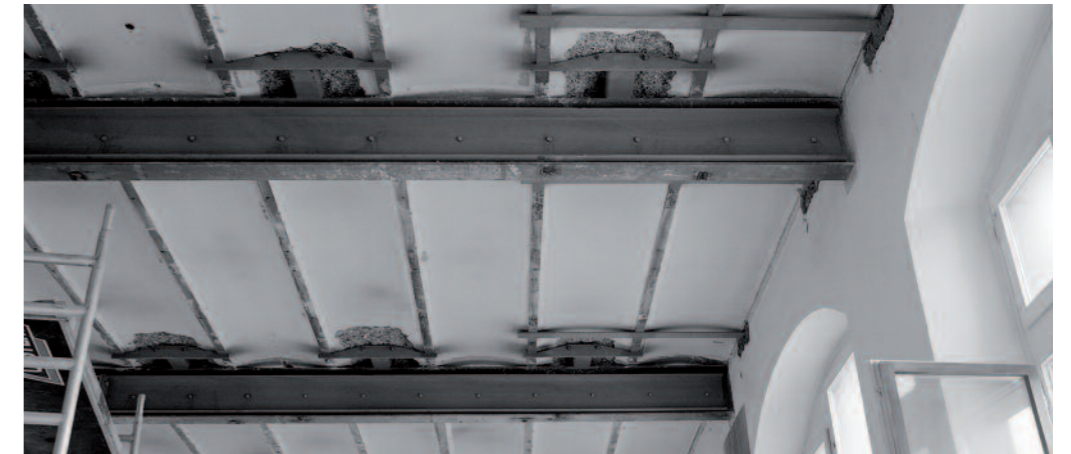
Neue Unterzüge und Verstärkungen der Stahlträgerdecke zur Erhöhung der Erdbebensicherheit
