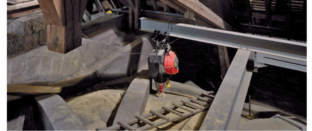
Dachstuhl über der Ruhmeshalle mit Stahlfachwerk zur Giebelaussteifung und motorisiertem Hängepunkt zur Aufhängung von Ausstellungsobjekten
