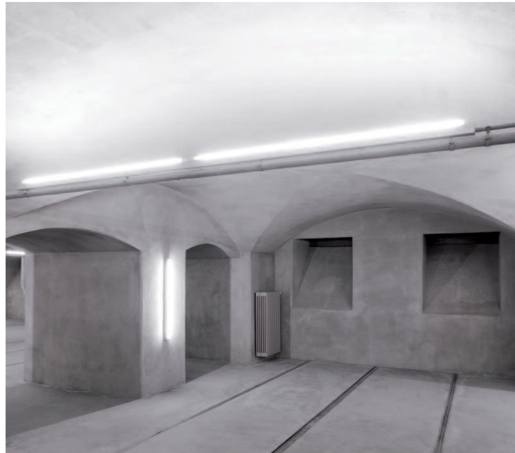
Tonnengewölbe mit Zugstangen im Sockelgeschoss
