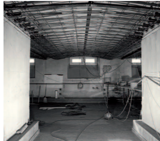
Unterbetonieren der Tonnengewölbe im Sockelgeschoss
