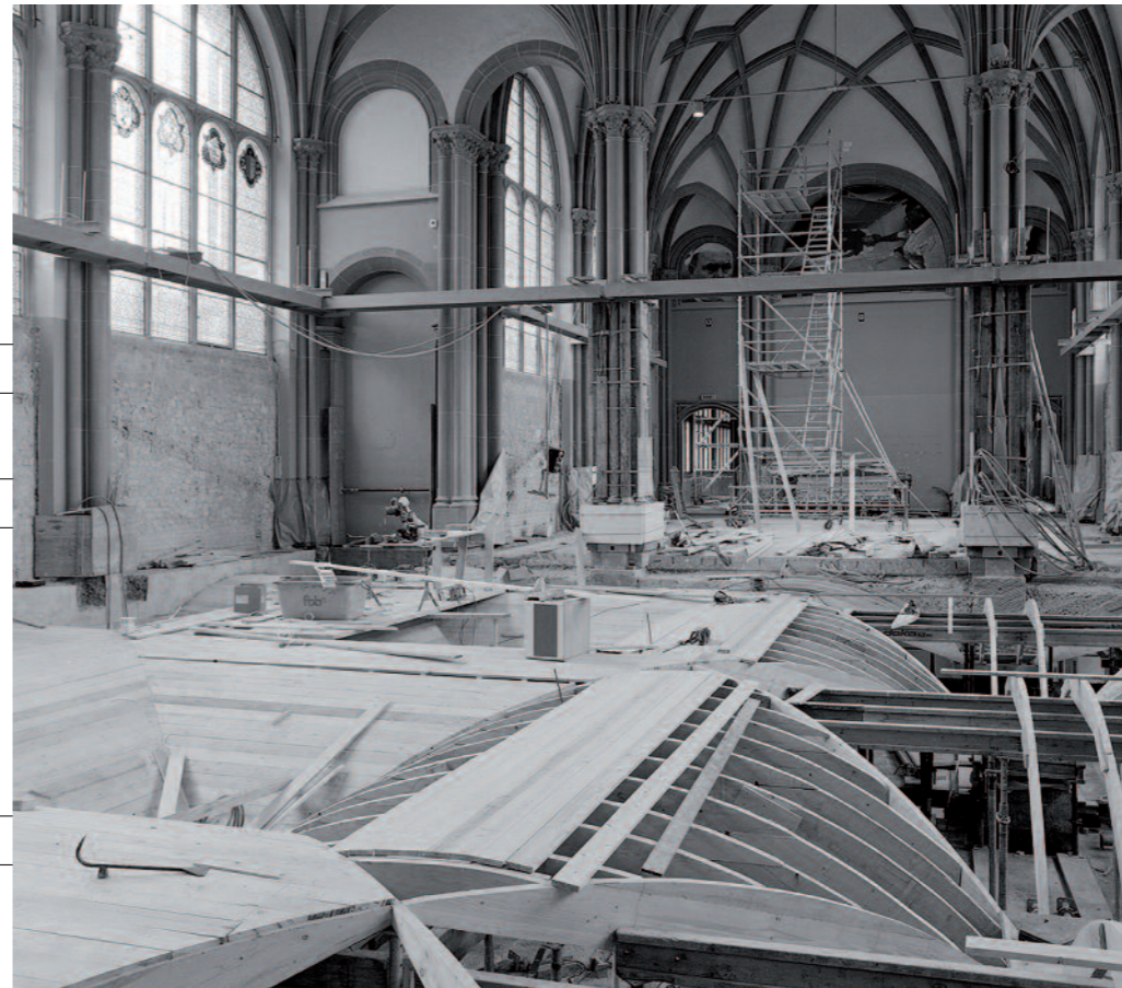
Neubau der Gewölbedecke über der Säulenhalle
