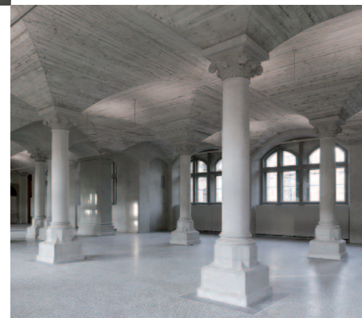
Säulenhalle mit neuer Sichtbetondecke im Erdgeschoss
