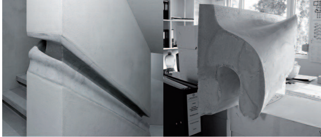
Handlauf im neuen Fluchttreppenhaus
