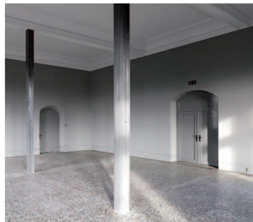
Entkleidete Stahlstützen in einem Seitenraum
