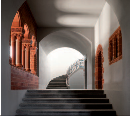
Aufgang zum Treppenturm Süd-West-Ecke
