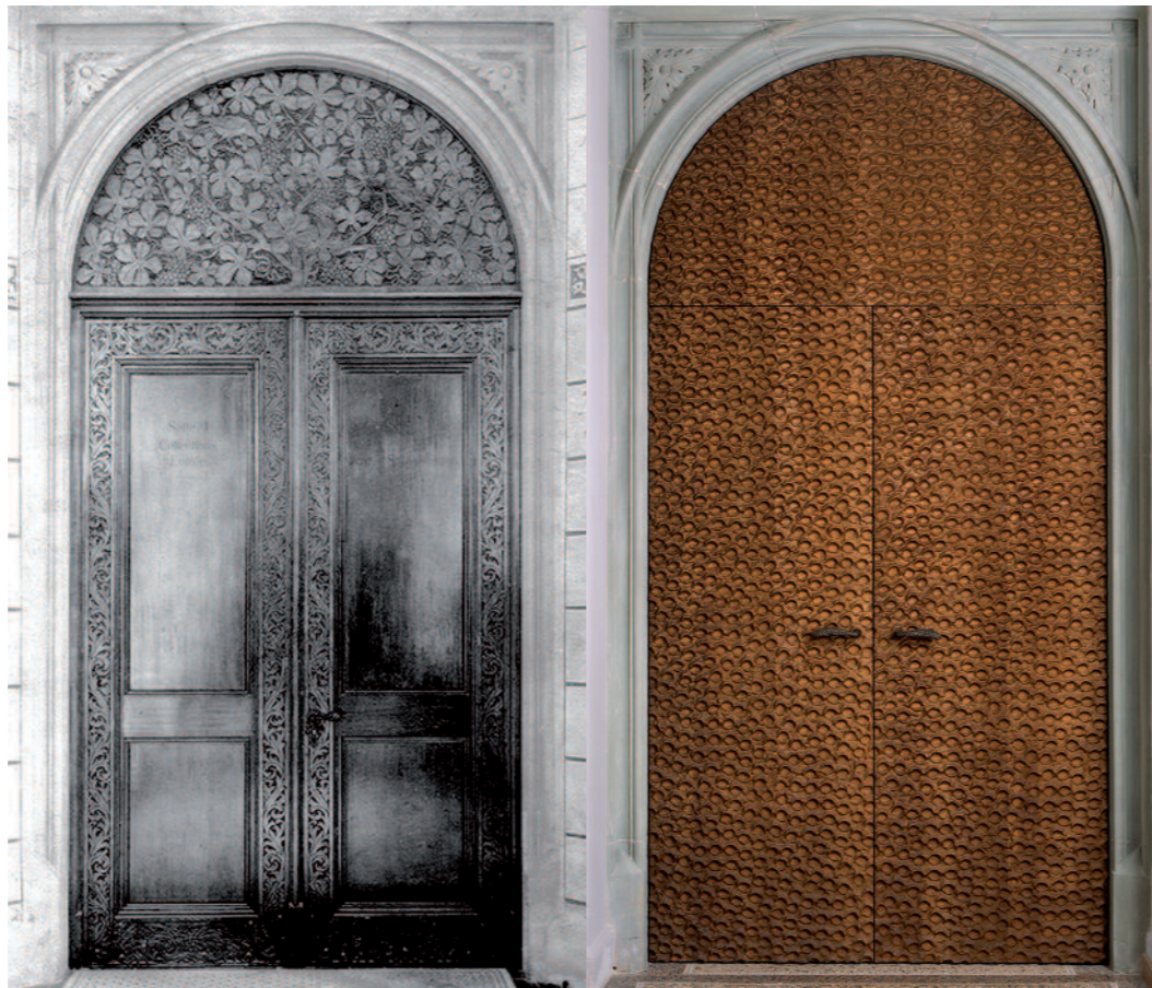
Historische Türe mit Flachschnitzereien und neue Brandschutztüre im Bahnhofflügel
