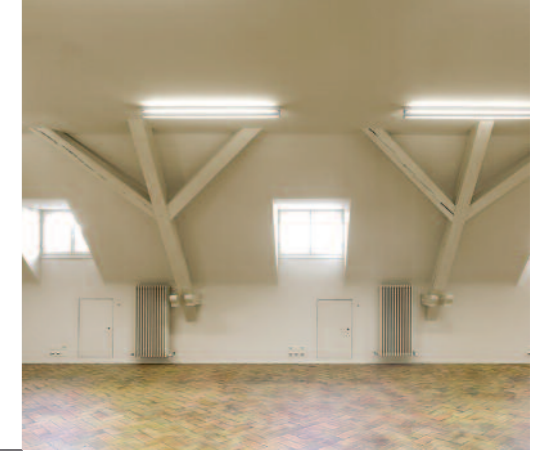
Dachraum in der Süd-West-Ecke
