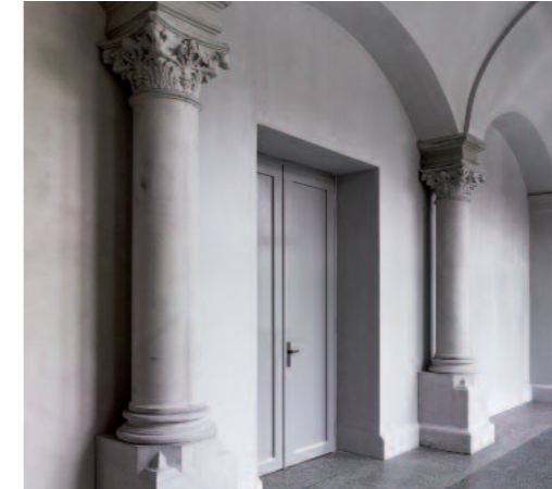
Wiederhergestellte Wand mit Betonsäulen im 1. Obergeschoss
