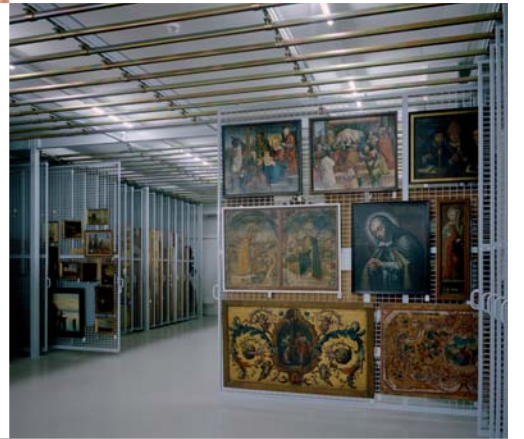
Gitterzuganlage im Objektdepot
