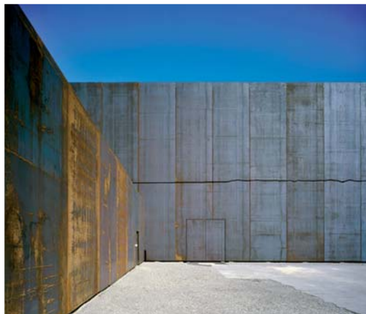
Innenhof mit Ansicht Objektdepot
