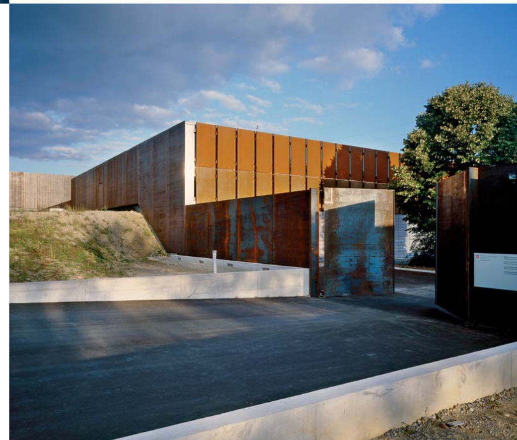
Haupteingang in die Gesamtanlage
