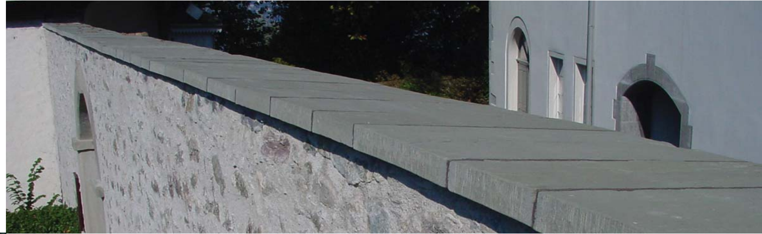
Mauerkronenabdeckung aus Sandstein
