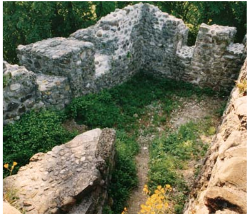
Blick in den Südteil des Hauptbaus mit dem Stumpf der Wendeltreppe
