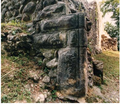
Sandsteinfassung des mutmasslichen Südtors
