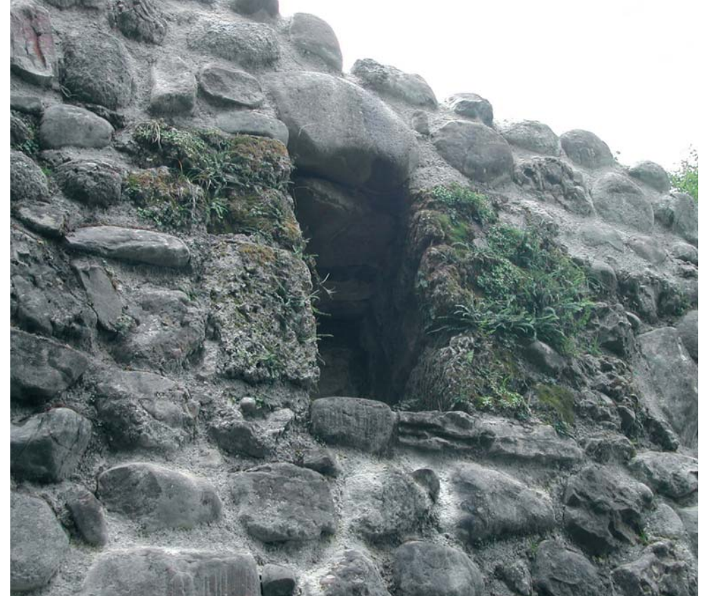
Mauerabschnitt vor der Sanierung. Ökologische Vorgabe war, die Tuffsteinköpfe frei zu lassen und die umgebenden Pflanzen zu erhalten.
