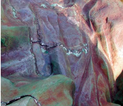
Schadensituation, partiell offene Risse und mit Fremdmaterial reparierte Bereiche bei den Bronzefiguren.
