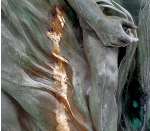
Die Risse und Fugen sind mit Bronzelot neu verschweisst und zu Gunsten der statischen Stabilität formal ergänzt worden.
