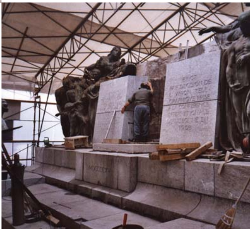
Die Texte beider Inschrifttafeln wurden im Massstab 1:1 am Original abgenommen und auf die neuen Steinplatten übertragen. In sorgfältiger Feinarbeit kopierte der Bildhauer die Texte in den neuen Stein.
