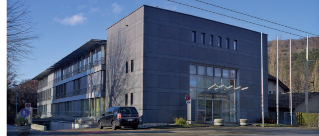
Nordecke des Gebäudes
