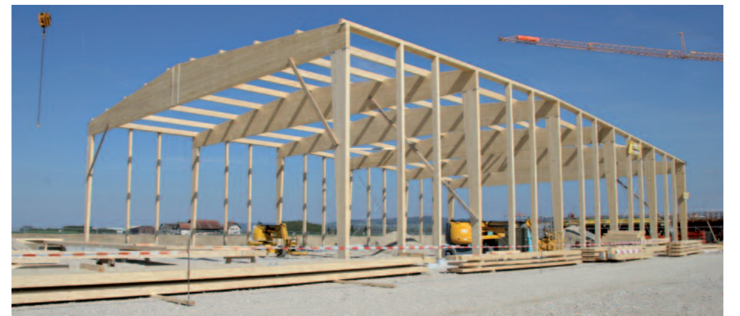
Aufrichtung der Holzkonstruktion
