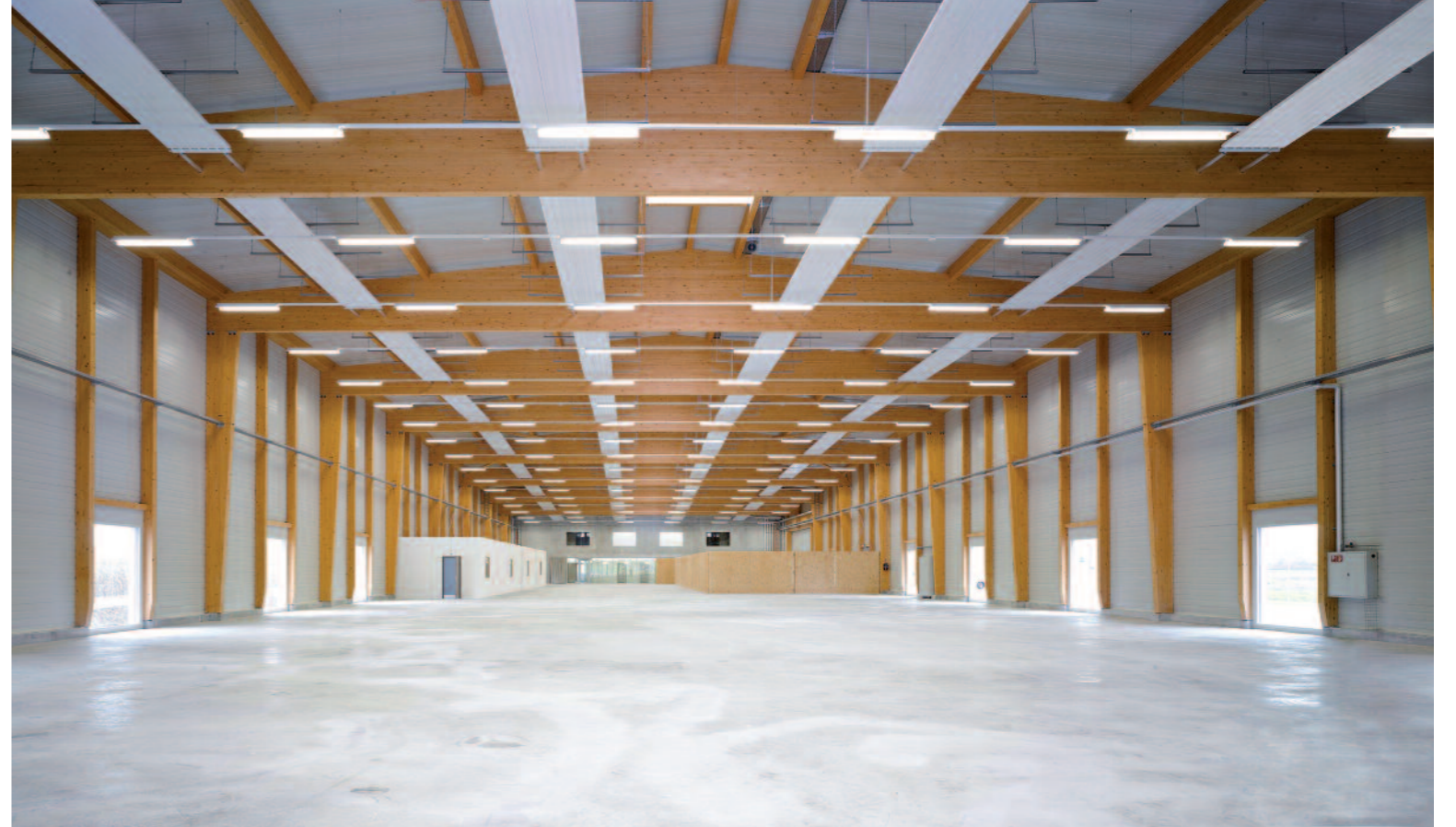
Innenansicht der Halle zur Lagerung der Wrackteile
