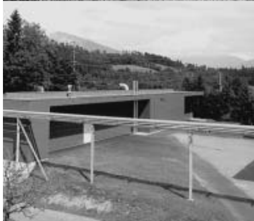
Südfassade mit Rohrstrasse
