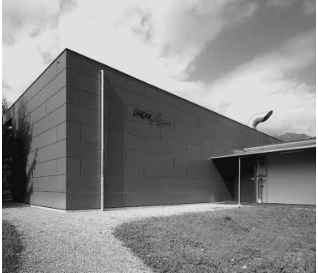
Ansicht aus Nordosten
