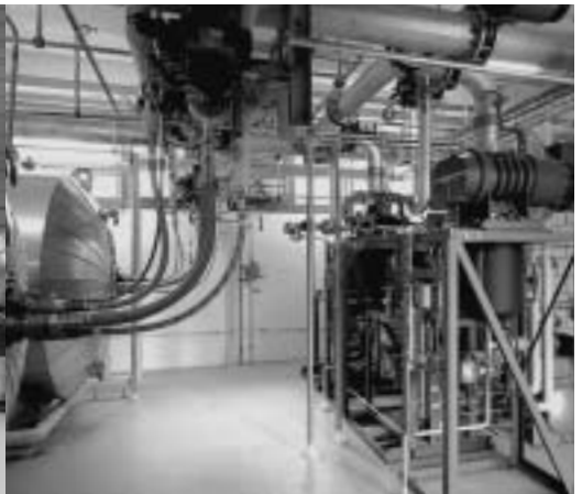
Nachtrocknung mit Vakuumpumpen
