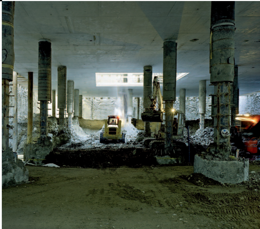
Erreichen der tiefsten Aushubkote
